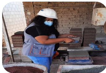
15. Vaceado de la mezcla en moldes de adoquines.
