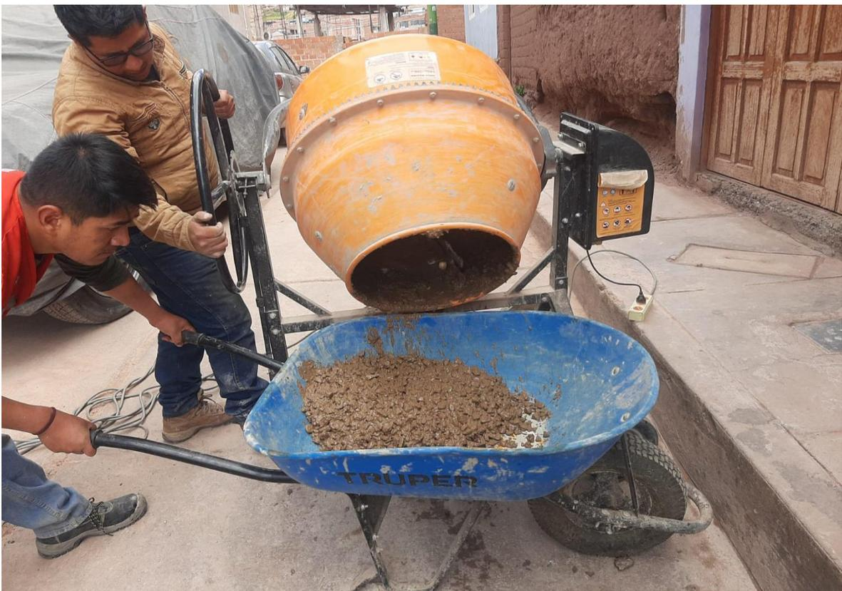
Figura 6. Mezcla de concreto incluyendo el aditivo (almidón de maíz).
