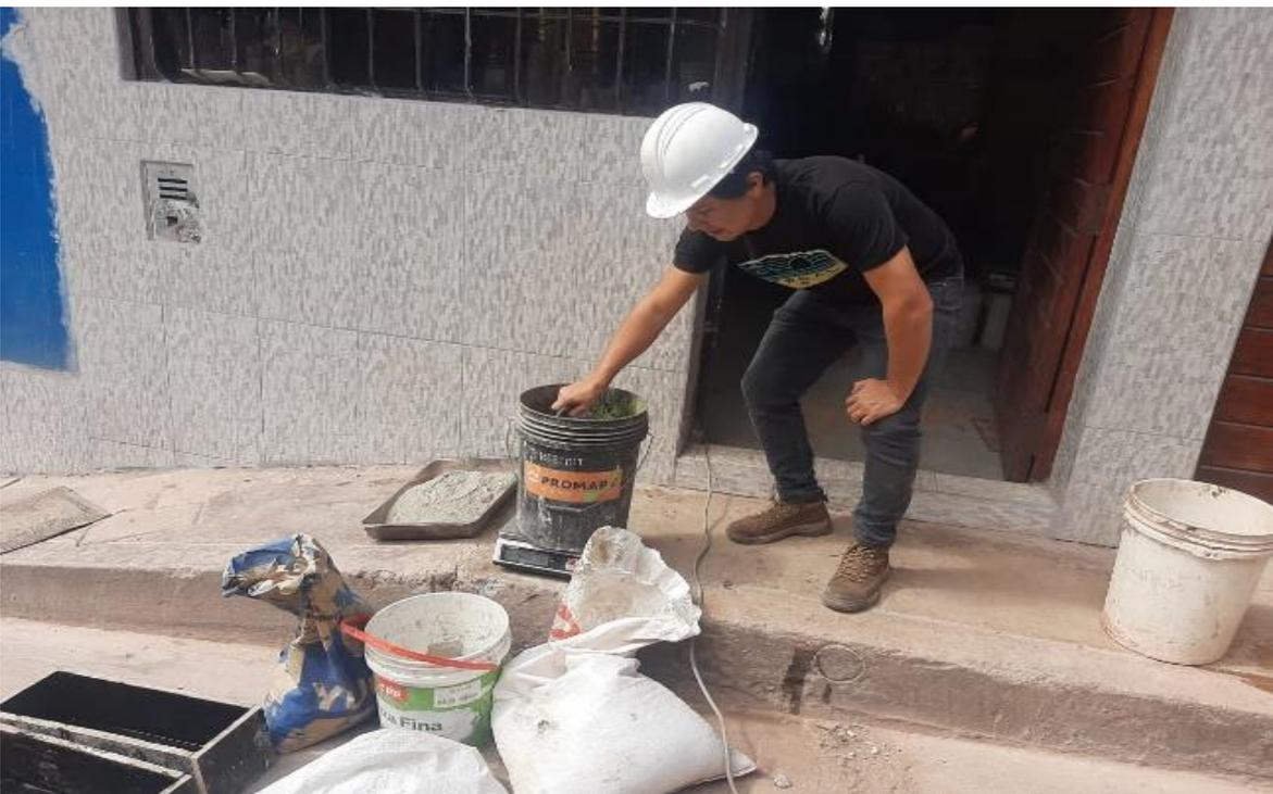
*Figura 4. Peso del agregado grueso, agregado fino, cemento y agua según tabla de dosificación.*
