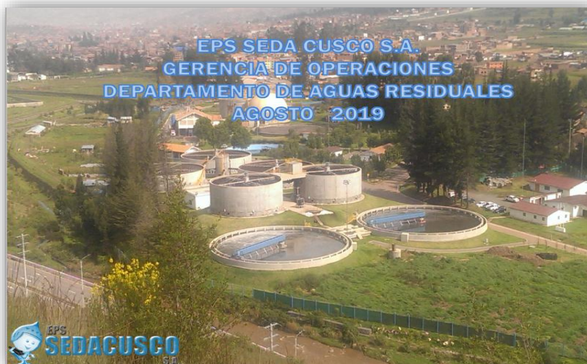
Figura 1. La Planta de Tratamiento de Aguas Residuales San Jerónimo– Cusco
