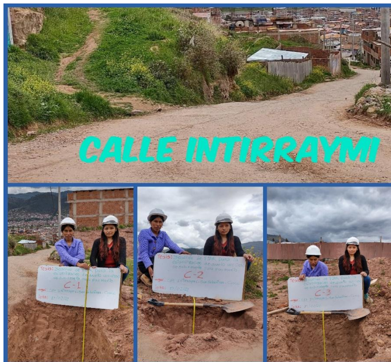
Figura 22. Realización de calicatas
