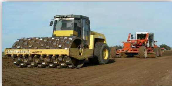
Figura 6. Rodillo Pata de Cabra: Estabilización por Compactación
