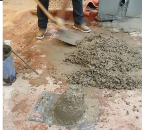
Figura 10. Elaboración del concreto - concreto fresco
