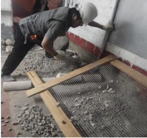
Figura 07. Zarandeo de agregados reciclados
