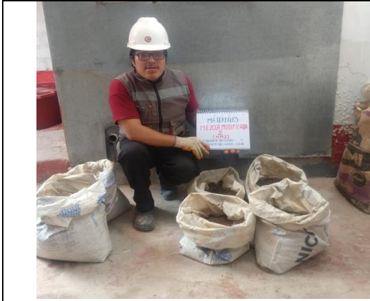
Figura 10. Materiales para las mezclas de concreto
