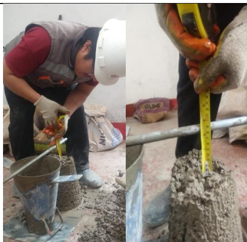
Figura 11. Ensayo de asentamiento cono de abrams
