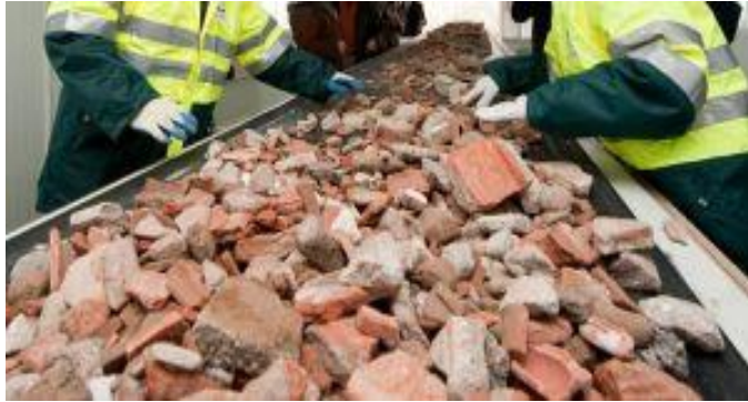
Figura 2. Residuos de la construcción y demolición
