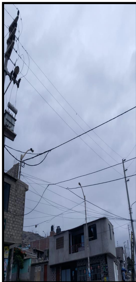
Figura 8: Vano de conductor Fase R reparado entre las Estructuras CH0640 – E2042119.
