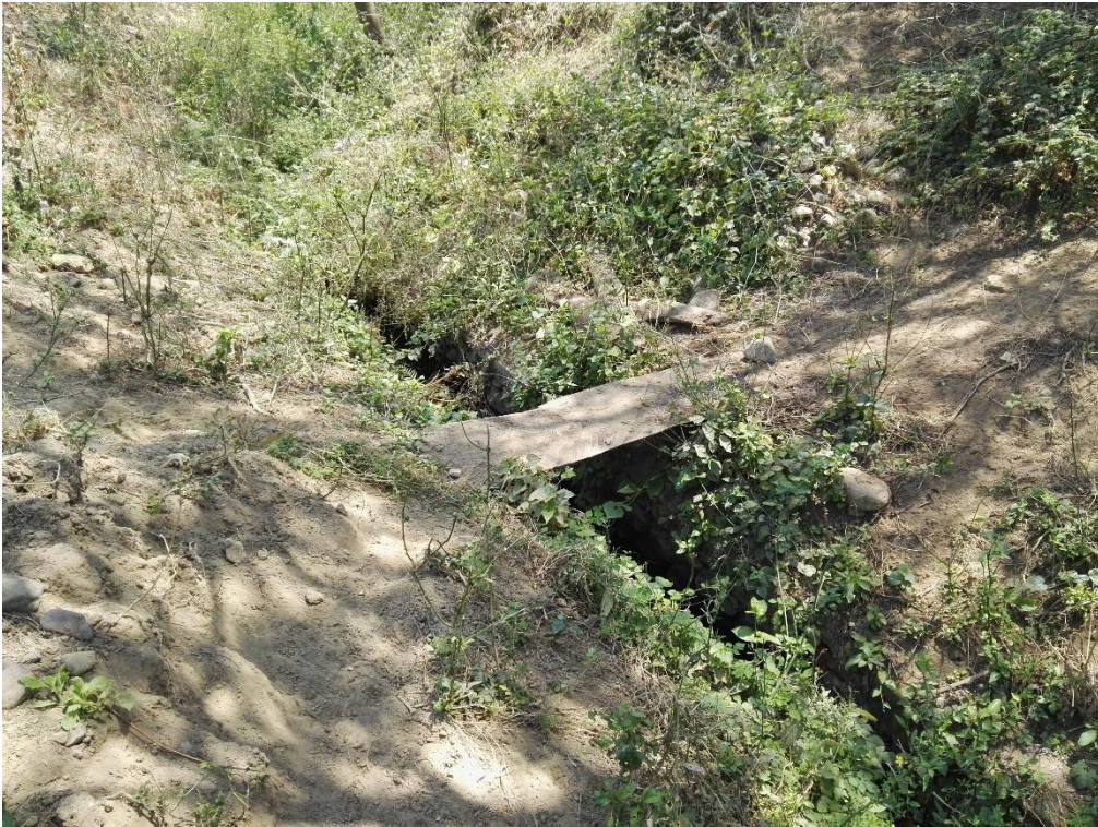
FOTO N° 03: Puente peatonal existente
