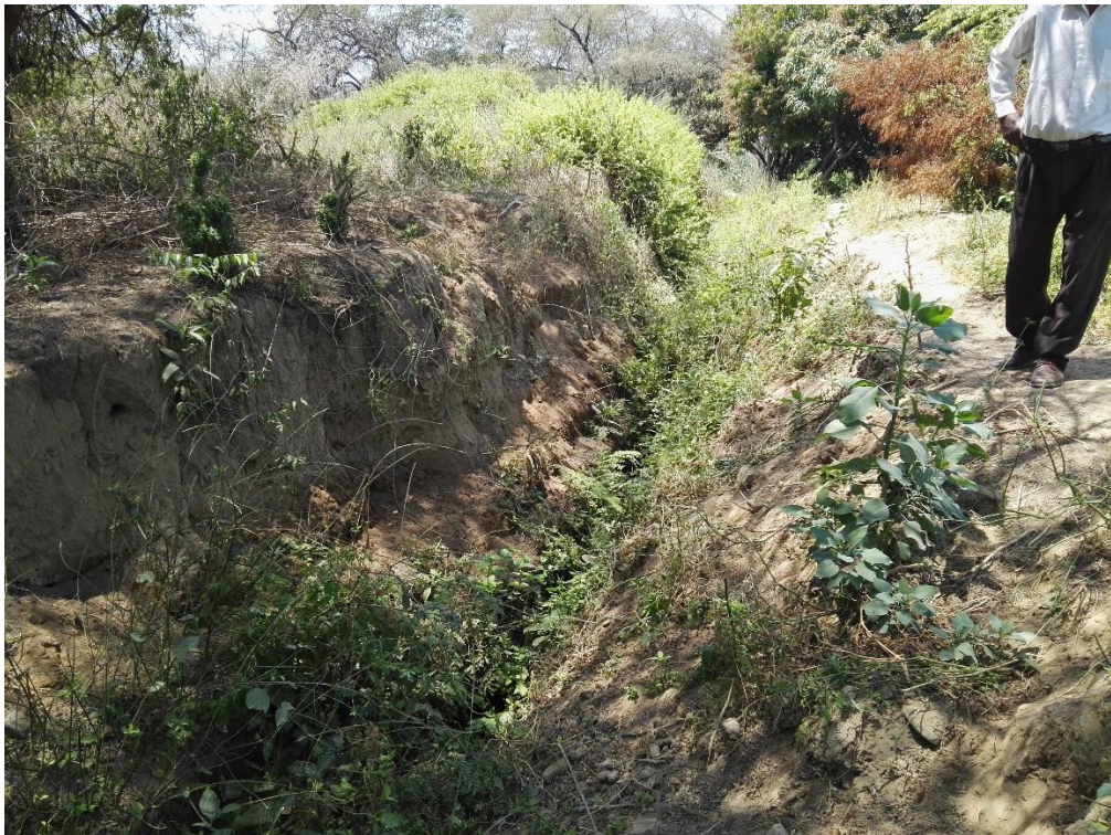
FOTO N° 04: Tramo del Canal El Manantial El Avio
