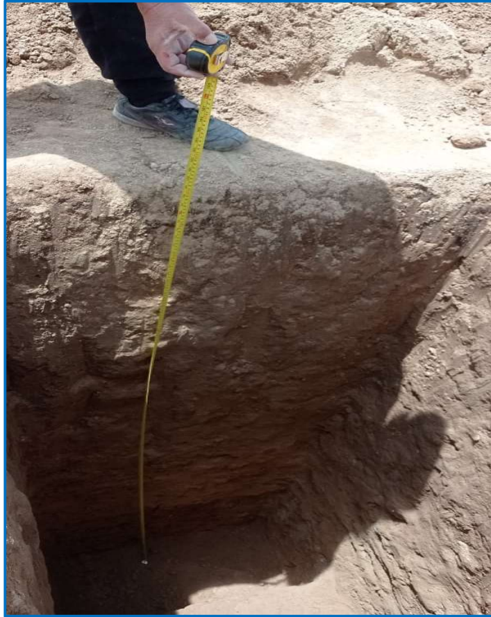
Figura N°05: Excavación de calicata.
