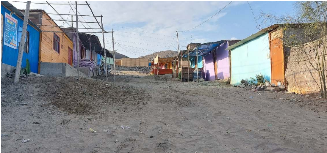
Figura 20: AH Lomas de San Pedro, emplazamiento el Cerro San Pedro en un terreno señalado como riesgo por desplazamientos.
