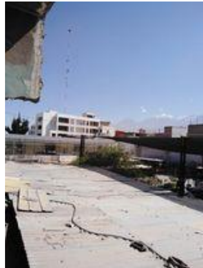
Figura 198 Vista del estado actual de la ex cárcel central del sur
