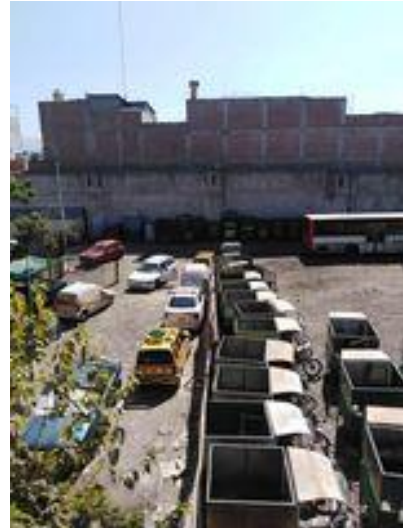
Figura 196 Vista del estado actual de la ex cárcel central del sur
