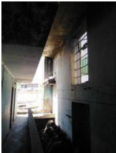
Figura 195 Vista del estado actual de la ex cárcel central del sur
