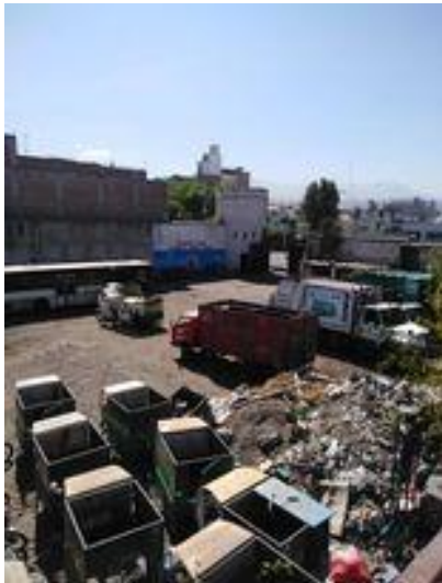
Figura 197 Vista del estado actual de la ex cárcel central del sur
