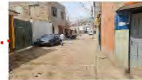
Fig 2: Calle Los Olivos. Ausencia de pista y veredas
