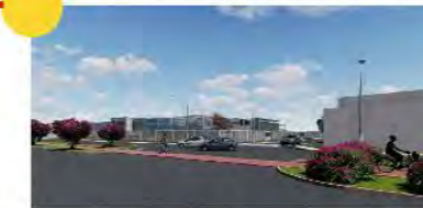
Intersección de Avenida San Pedro y Guadalufo Silva
