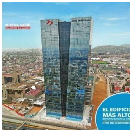
Figura 1. Edificación de la Nueva sede del Banco de la Nación ubicado en el distrito de San Borja en el 2015. Tomada por Cosapi, 2015.
