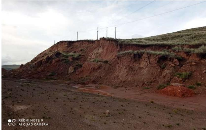
*Figura 1.2. falla de talud.*
