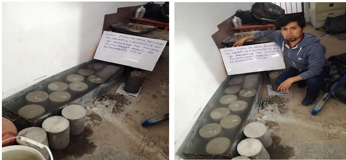
Figura 21. Curado de probetas de concreto
