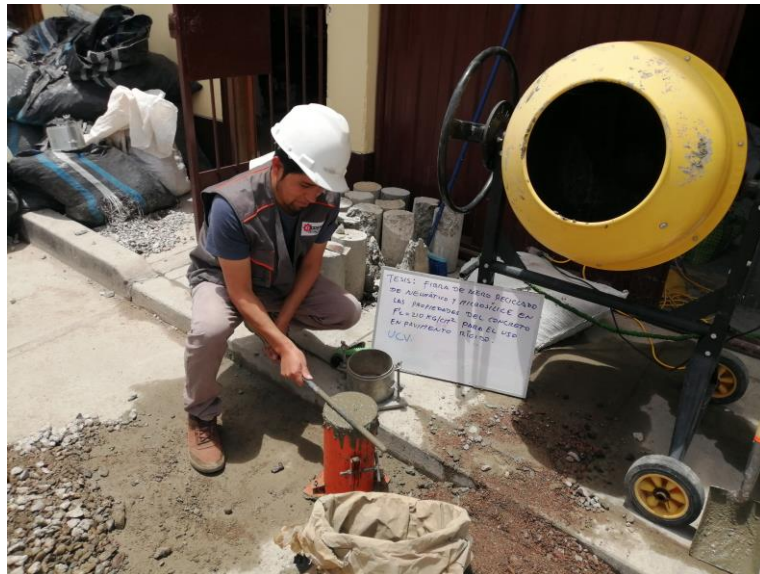
Figura 18. Elaboración de las briquetas de concreto
