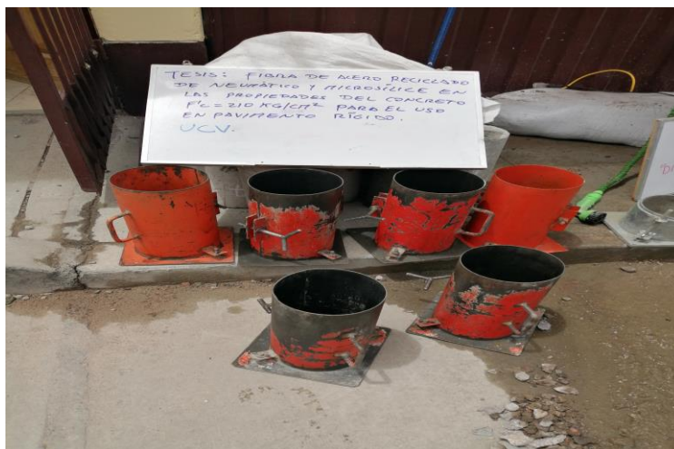
Figura 15. Preparación y nivelado de los moldes para briquetas de concreto
