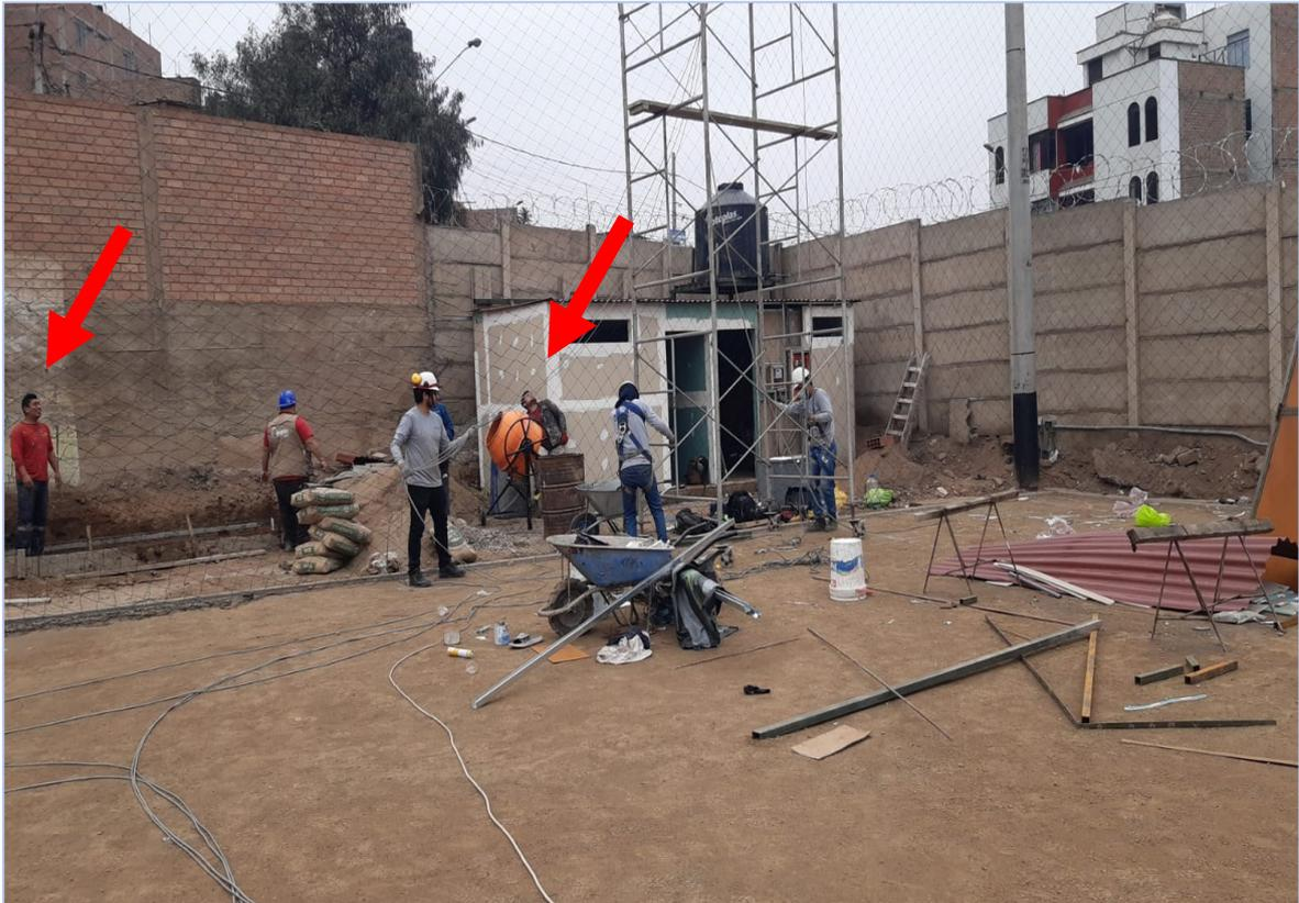
*Figura 14. Evidencia de falta de supervisión de uso de EPPs*
