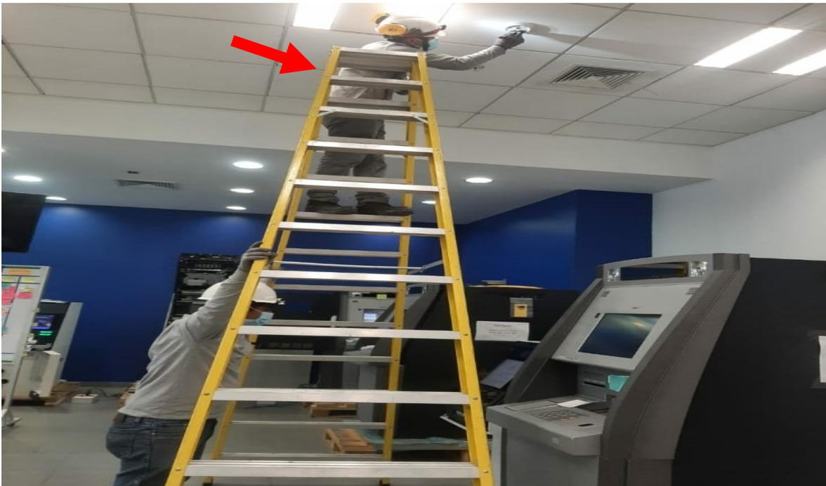
*Figura 24. Evidencia de condiciones de trabajo que suponen riesgo de caídas*
