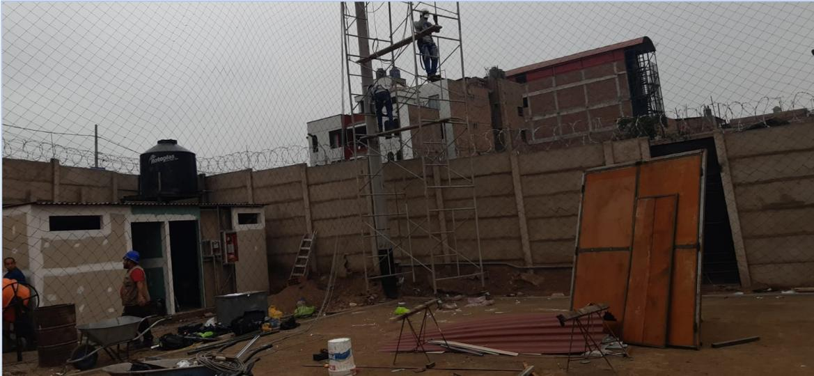
*Figura 23. Evidencia de falta de señalización de riesgos*
