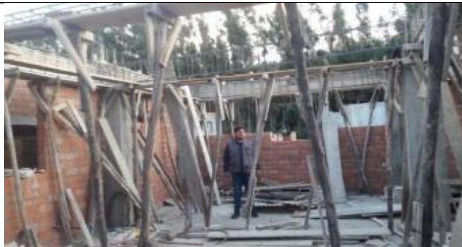
Visita en la obra de construcción de la edificación
