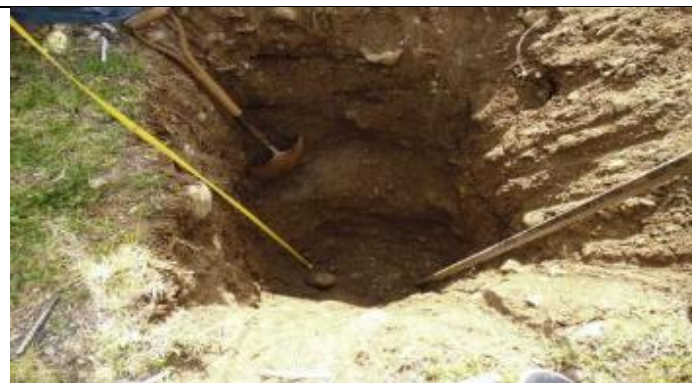
Medición de profundidad de calicata
