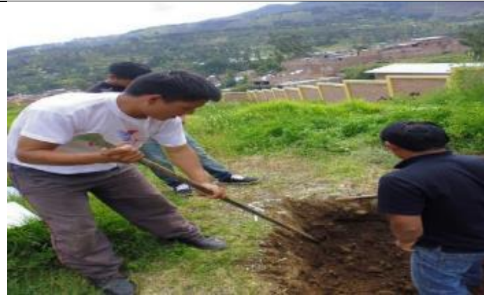
Realizacion de calicata para muestra de suelo
