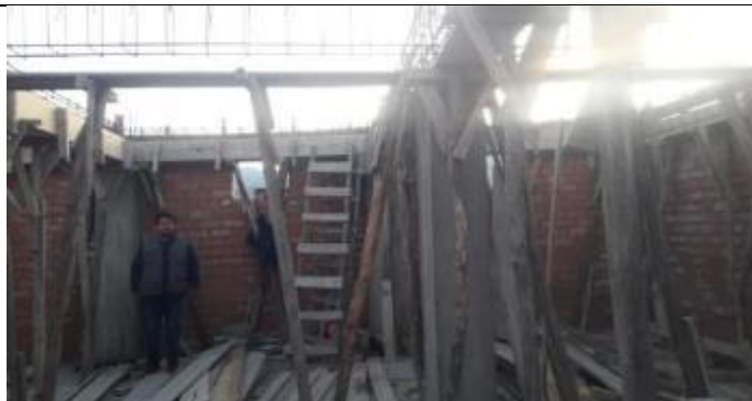
Armado y encofrado para losa
