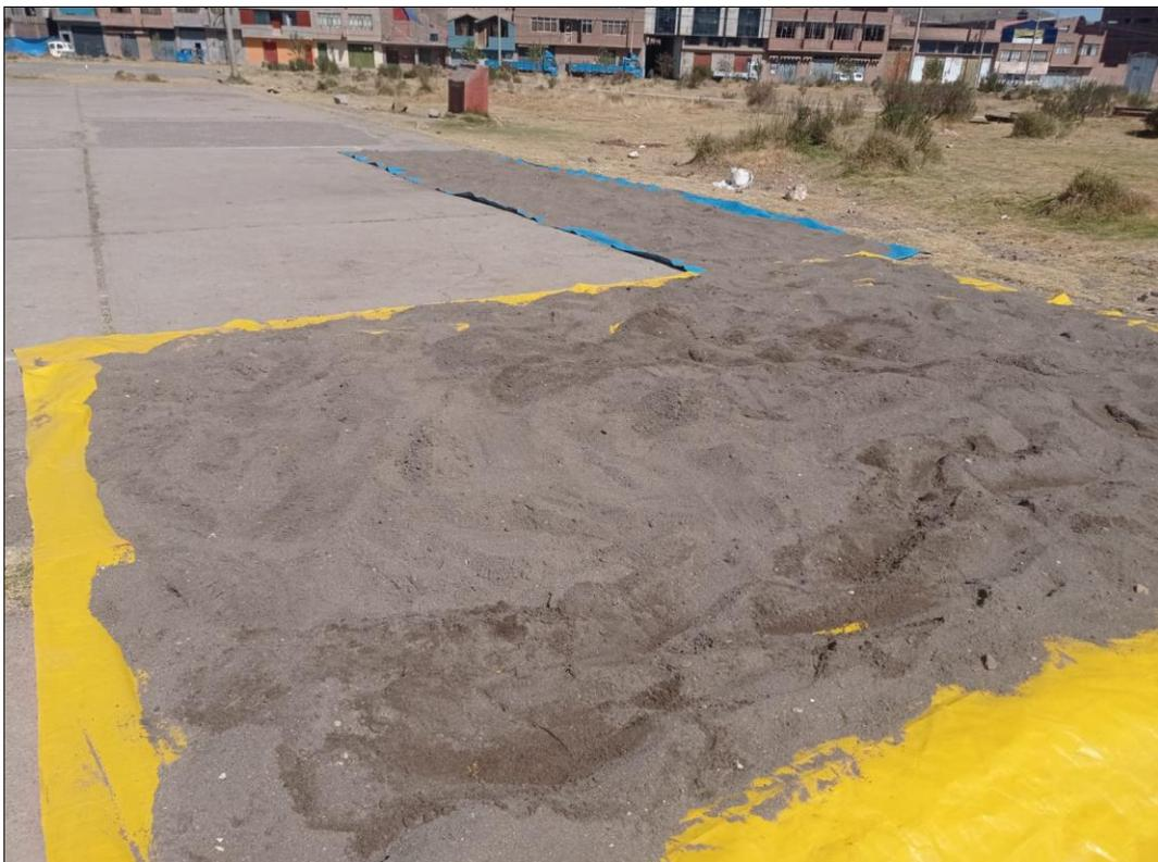
*Imagen:* Secado del agregado al aire
