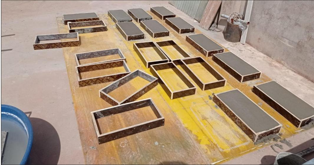
*Imagen:* Bloques de concreto celular vaciados en los moldes.
