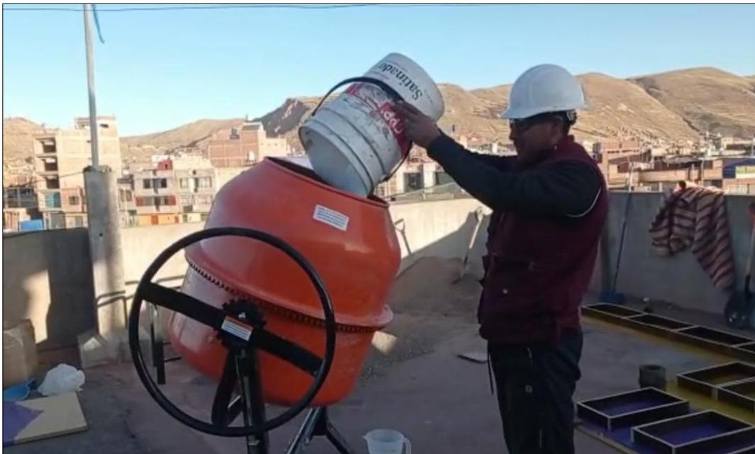
*Imagen:* Mezclado de arena, cemento, agua y espuma para los bloques
