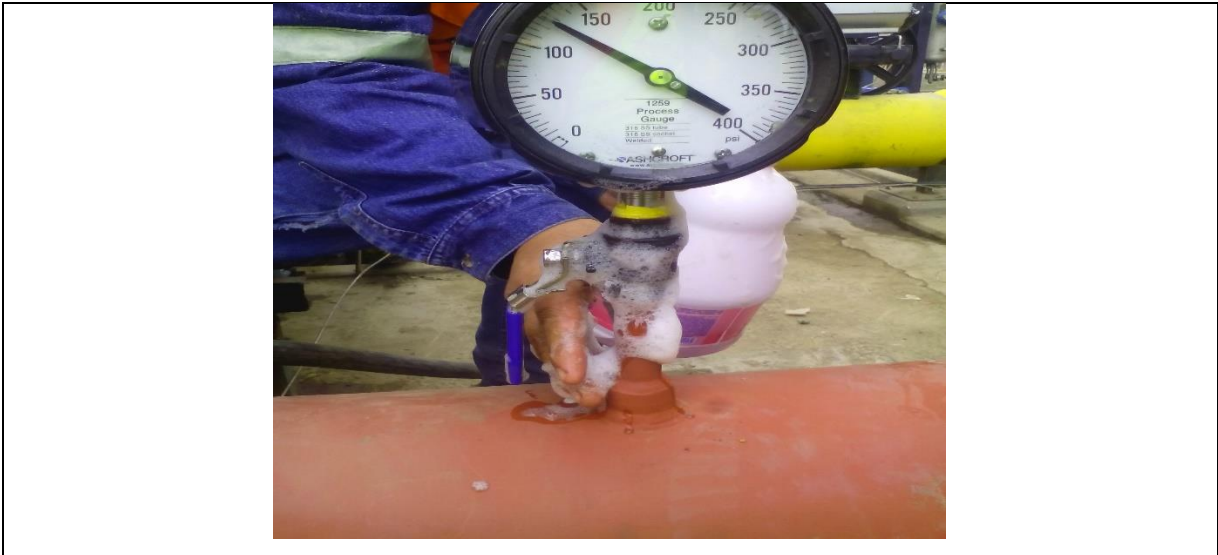
Figura 14. Revisión de tuberías antes del arranque.
