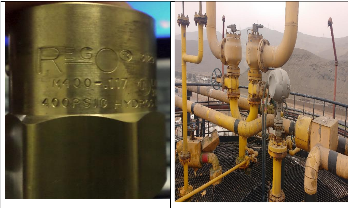
Figura 32. Válvulas de alivio de esfera pilotada, de retorno y atmosférica. Fuente: Elaboración propia.
