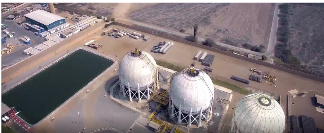
Figura 2. Planta de Almacenamiento Fuente. Solgas S,A.
