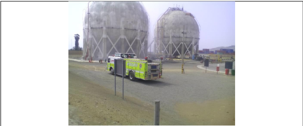
Figura 15. Montaje de la nueva motobomba aplazamiento hasta contar con camión bomba como sistema de contingencia.
