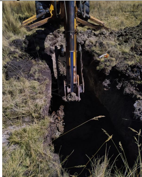
Fotografía 3. Excavación de la calicata
