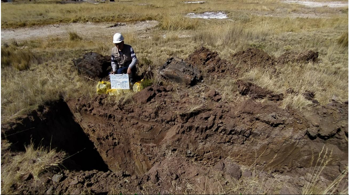
Fotografía 13. Zona de excavación de calicata a una profundidad de 3.00m
