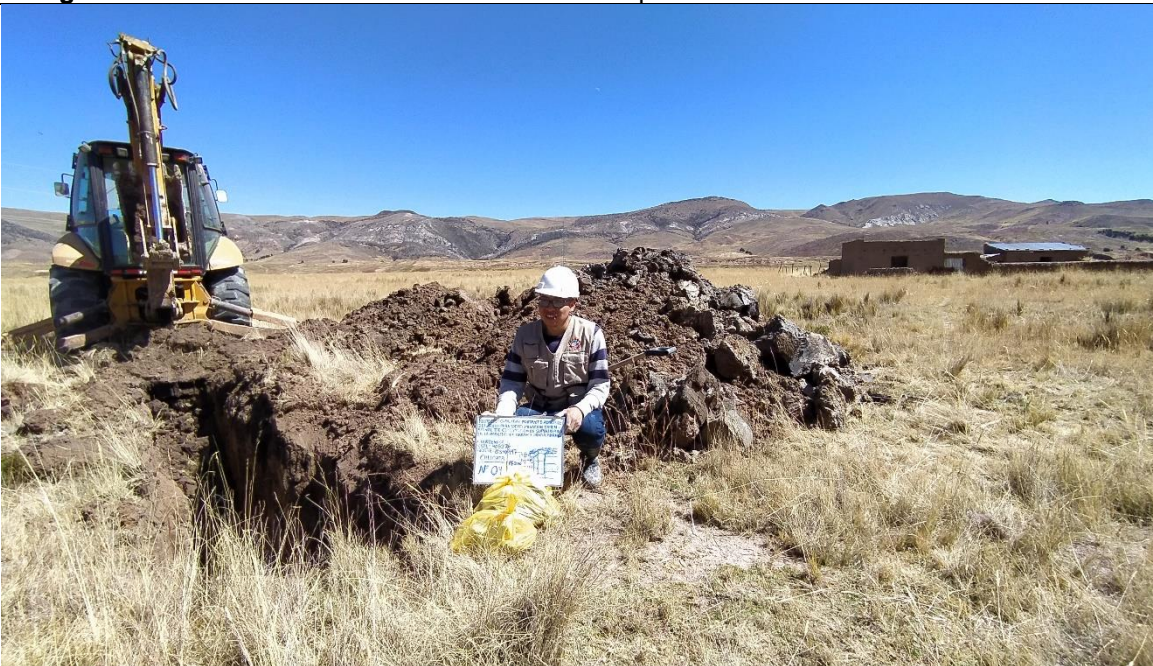
Fotografía 14. Zona de excavación de calicata a una profundidad de 3.00m
