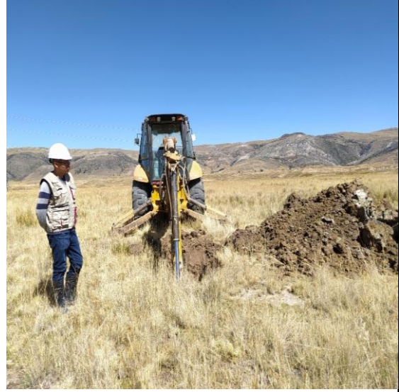
Fotografía 2. Excavación de la calicata
