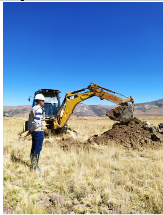
Fotografía 4. Excavación de la calicata
