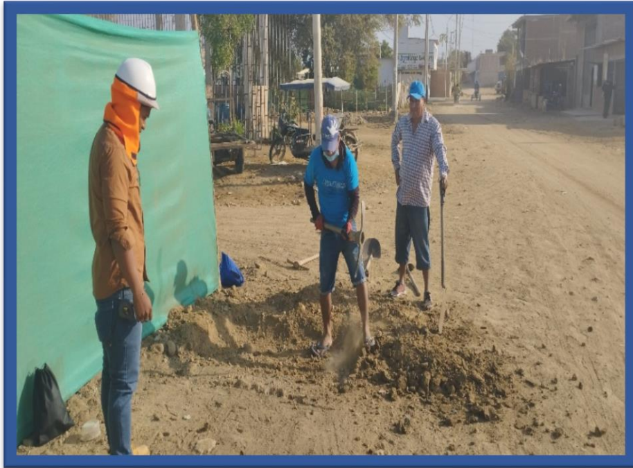
Figura 34: Inicio de excavación calicata 01
