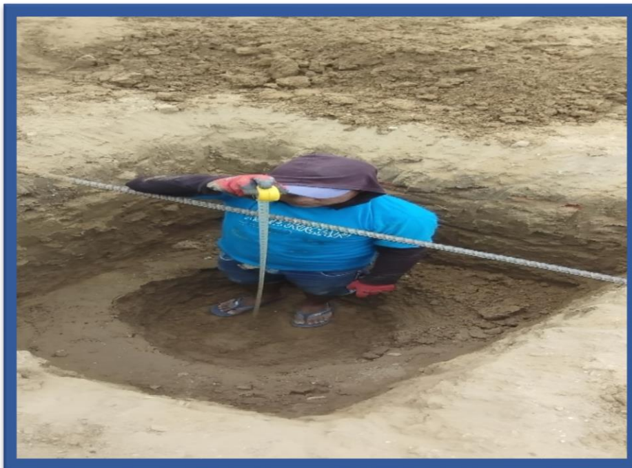
Figura 35: Excavación de calicata 01
