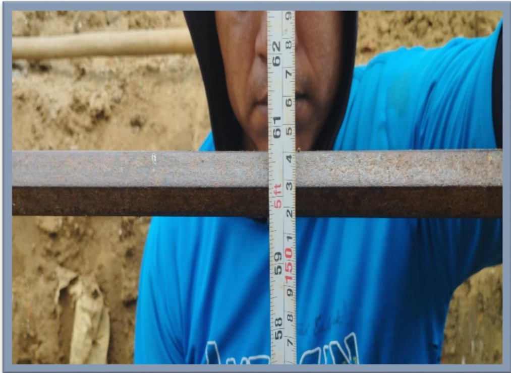
Figura 38: profundidad de 1.5 metros calicata 02
