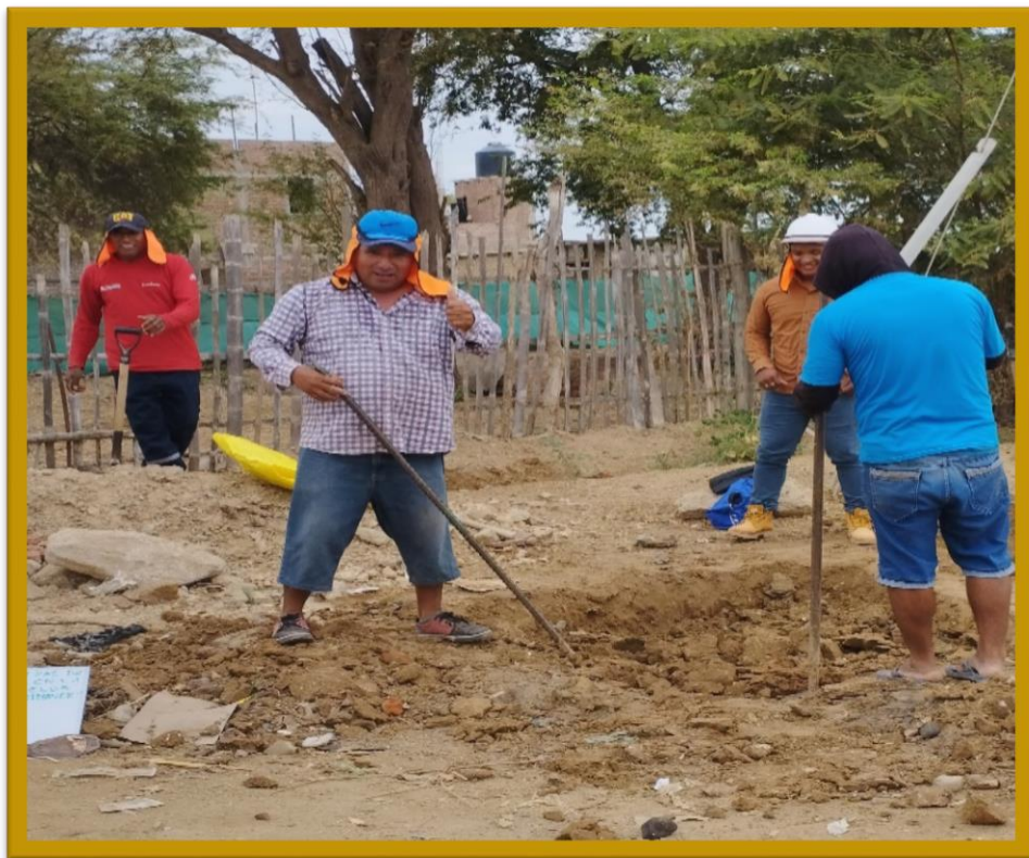
Figura 37: Inicio de excavación calicata 02
