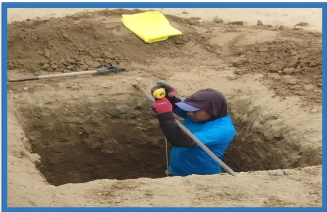
Figura 41: excavación total de calicata 03
