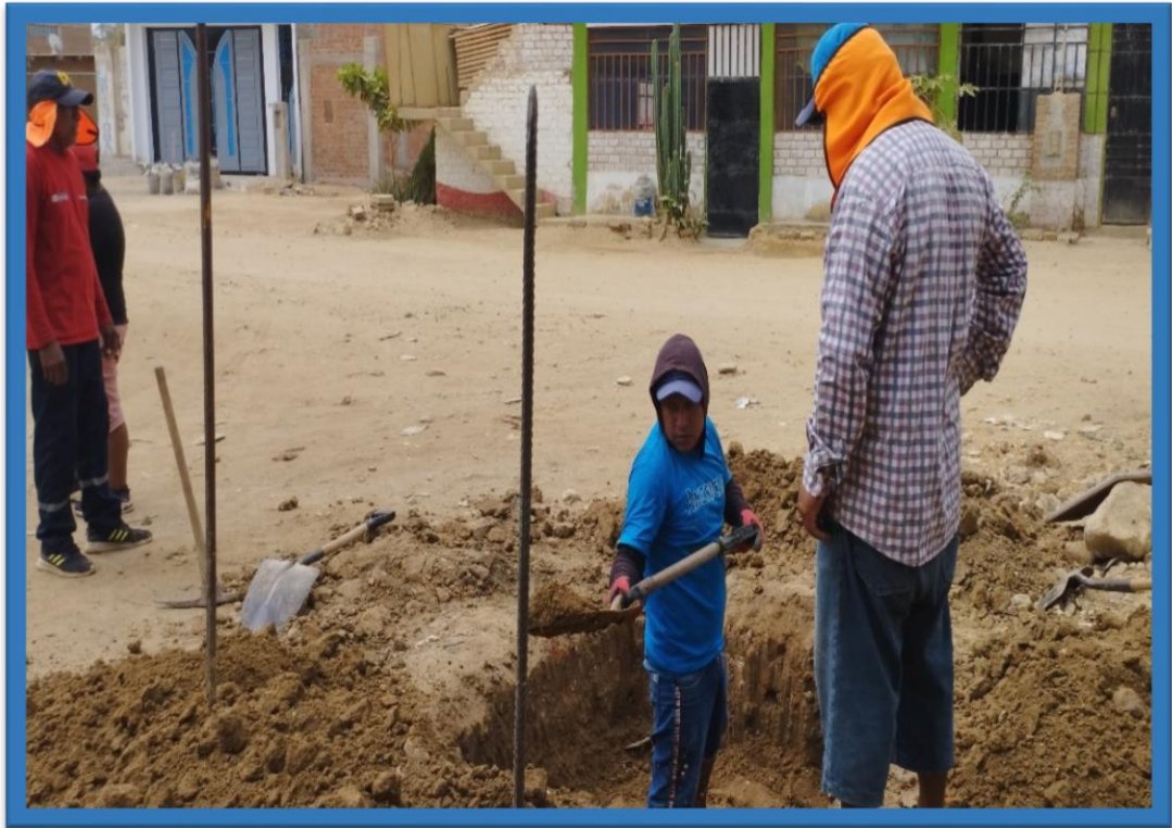
Figura 40: inicio de muestreo de calicata 03
