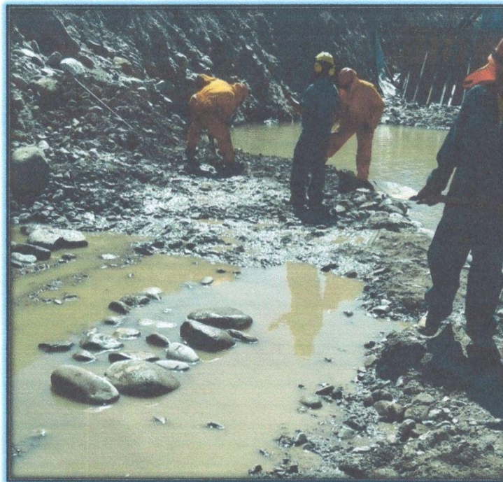
Mejoramiento de plataforma con personal debido a presencia de agua
