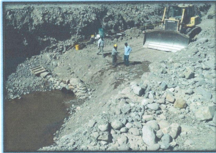
Mejoramiento de plataforma con tractor de la municipalidad debido a presencia de agua
