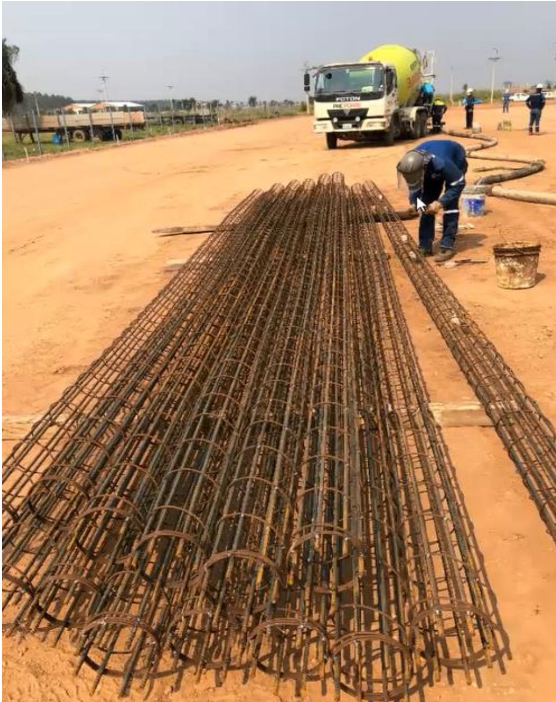
Figura 4: Malla de Pilotes
