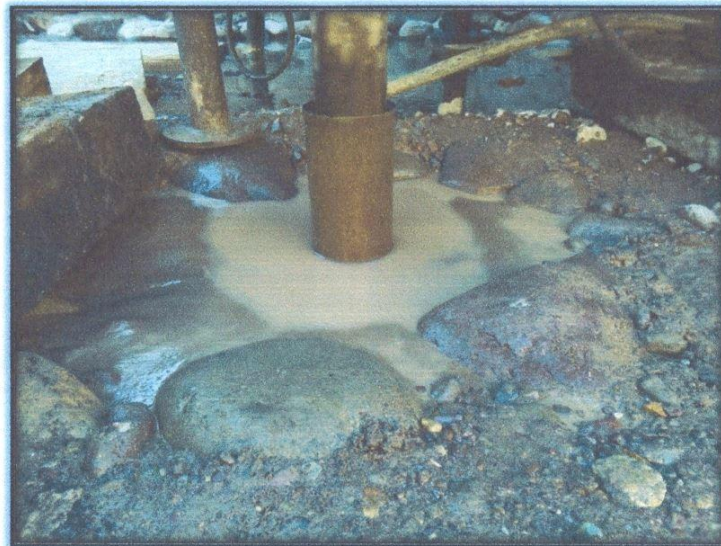
Al perforar con broca diamantina se lava arcilla
