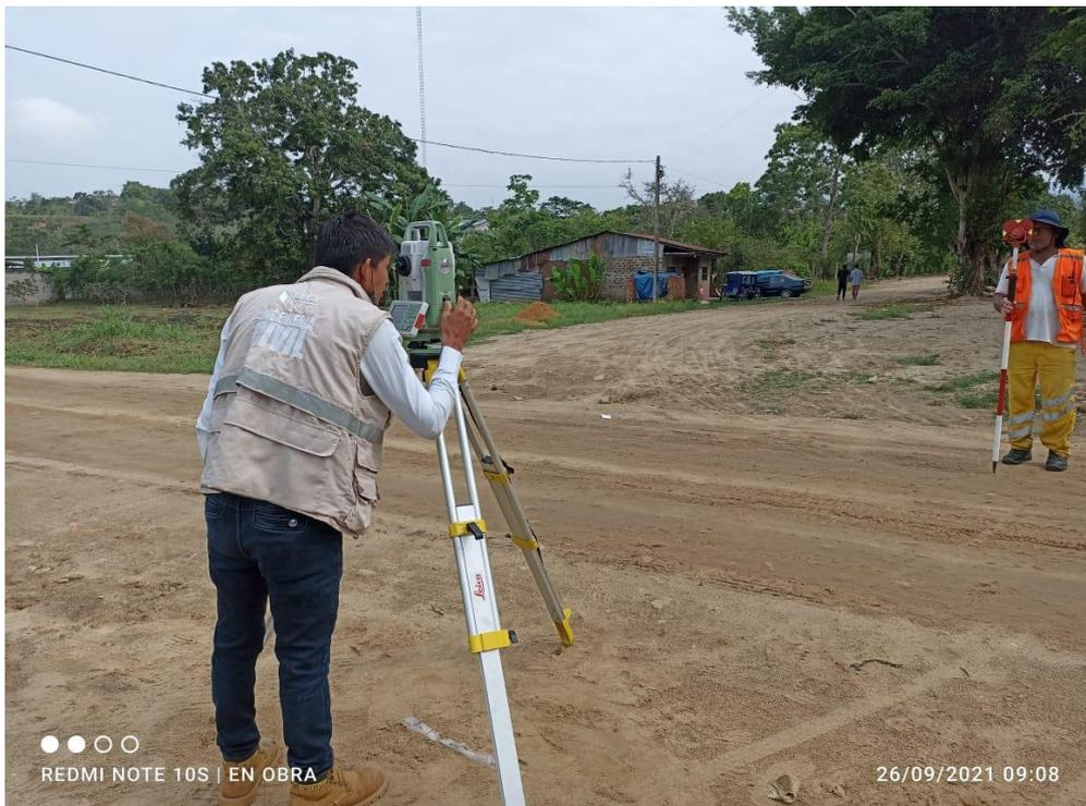
Vista fotográfico N°11. Levantamiento topográfico con la estación total jr. Libertadores.
