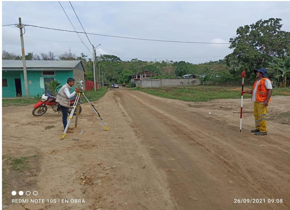
Vista fotográfico N°10. Levantamiento topográfico con la estación total jr. Las rocas
