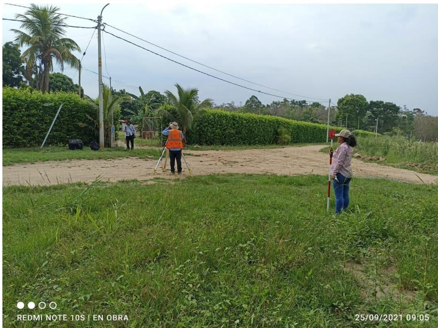
Vista Fotográfica N°9. Levantamiento topográfico con la estación total jr. Tarapoto
