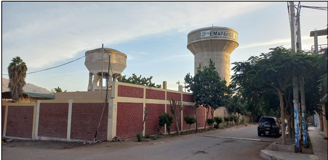
IMAGEN 06.- Vista frontal de reservorios elevados de 450 m 3 (izquierda) y 1500m 3 (derecha)
