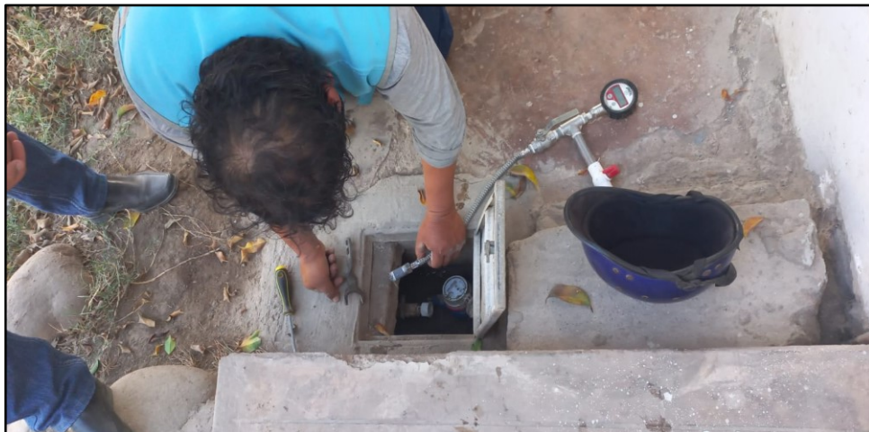
IMAGEN 02.- Apoyo técnico para instalación manómetro en caja de registro de agua con medidor de ½"
