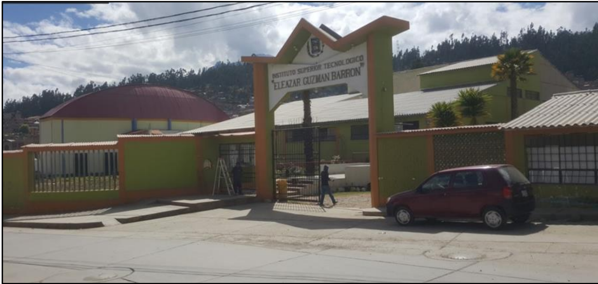
Figura 42: Fachada principal del Instituto Superior Eleazar Guzman Barron.
