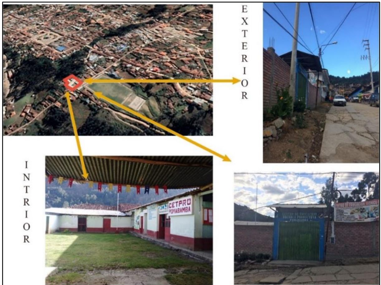
Figura 26: Vistas interior y exterior del CETPRO.
