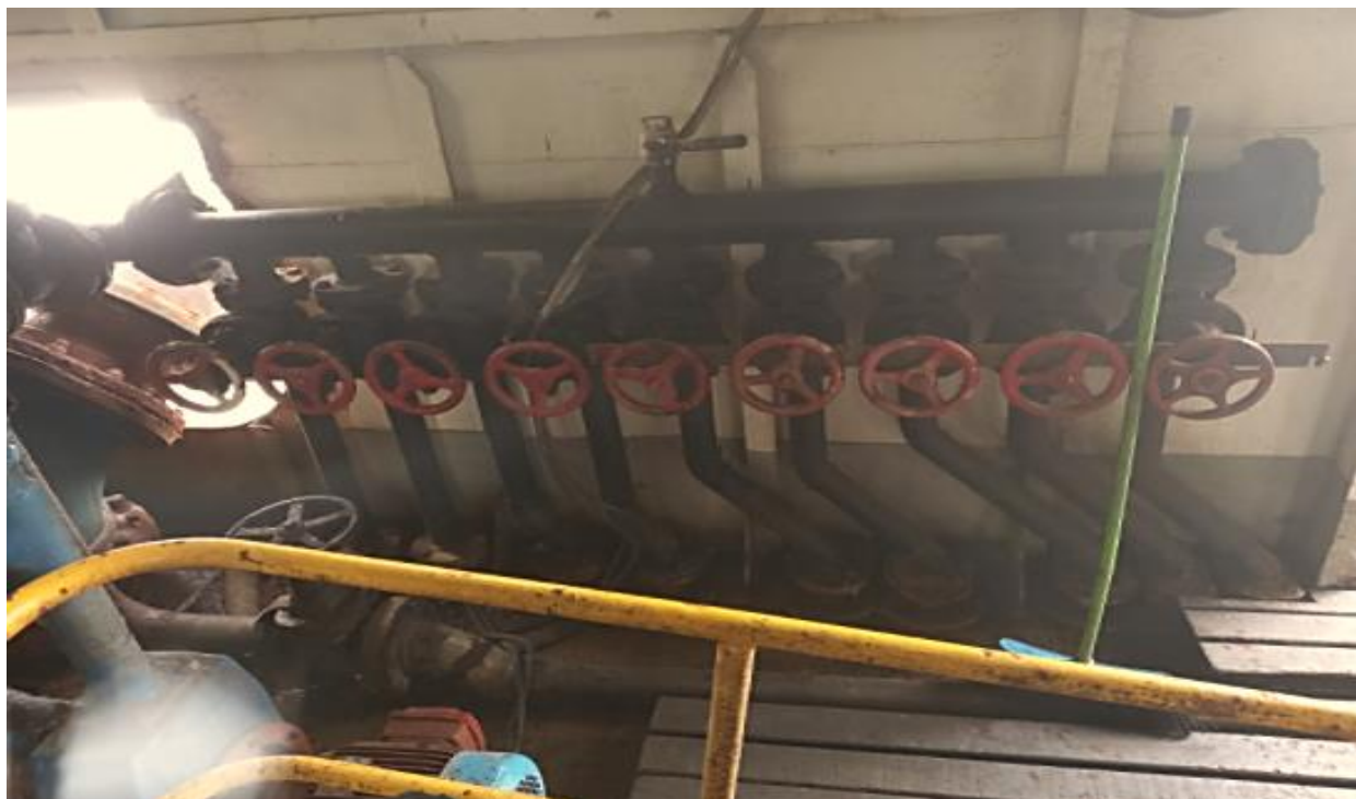
Actividades cotidianas de la Empresa – Reparación de tuberías
