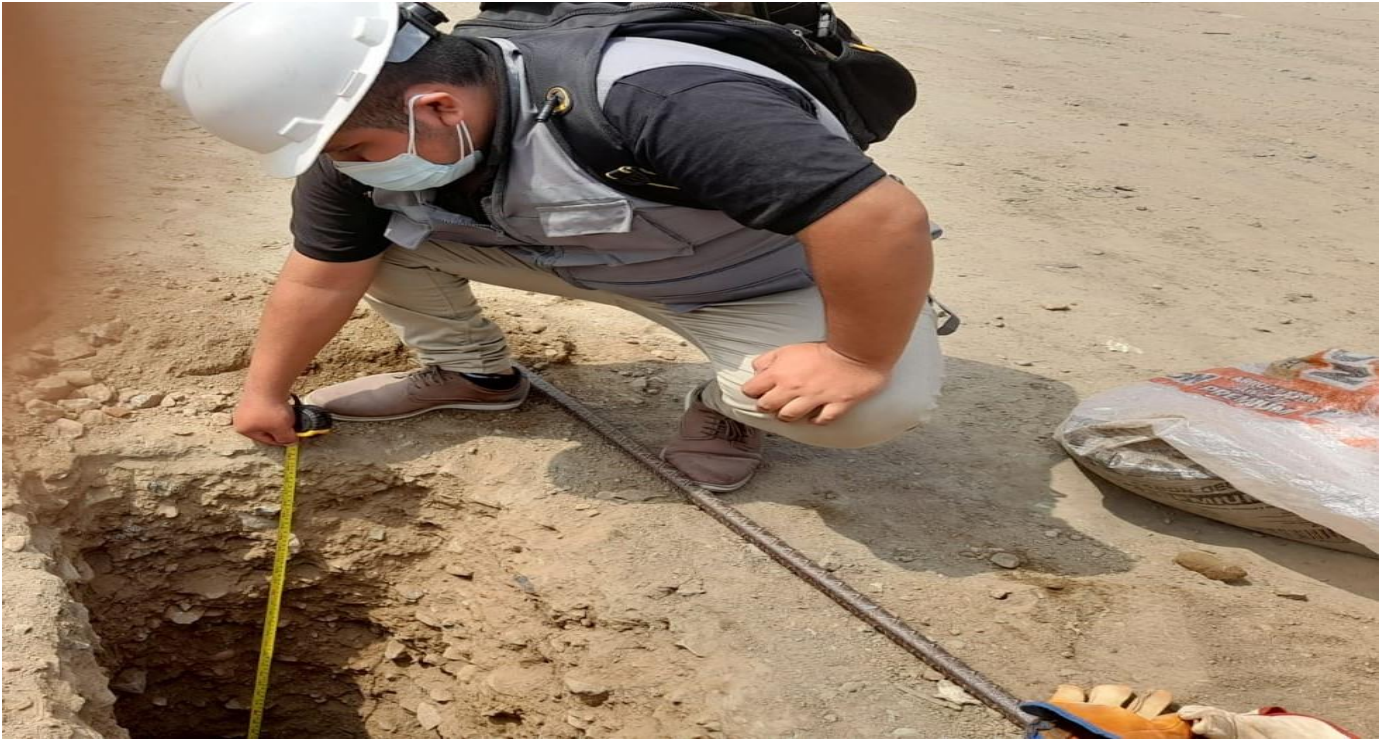
Calicata N°1 - Av. Huayna Cápac
