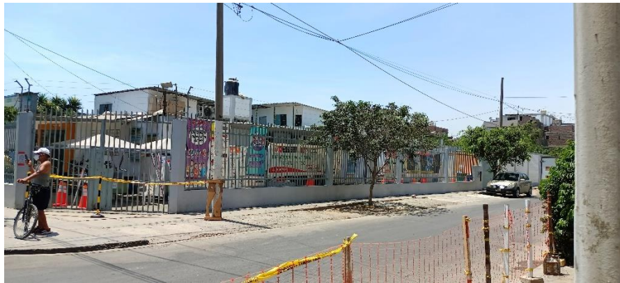
Figura 33. Vista del centro de salud desde la Ca. los Yupanqui.
