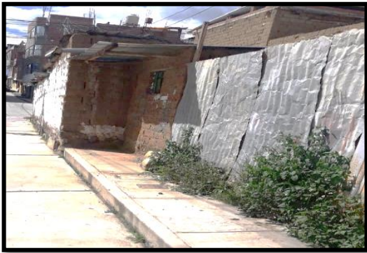
Figura N° 05: Veredas invadidas por viviendas en la urb. de San Miguel - Shancayan.
