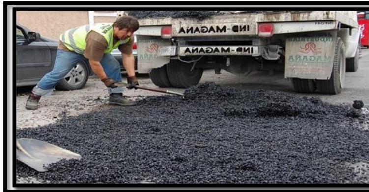
Figura 2. Mezcla asfáltica en caliente
