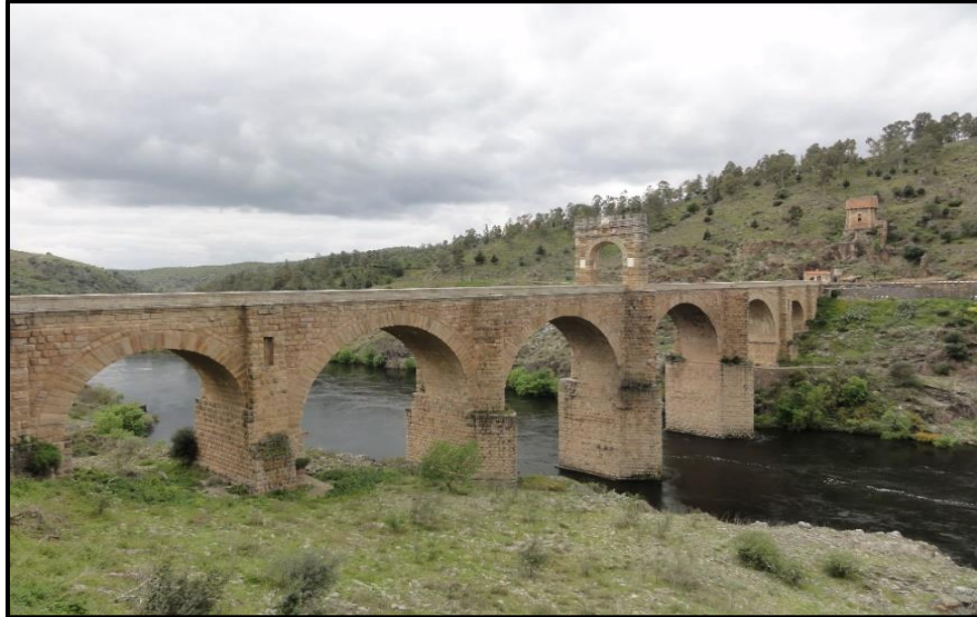
Figura 32: Puente romano de Alcántara.
