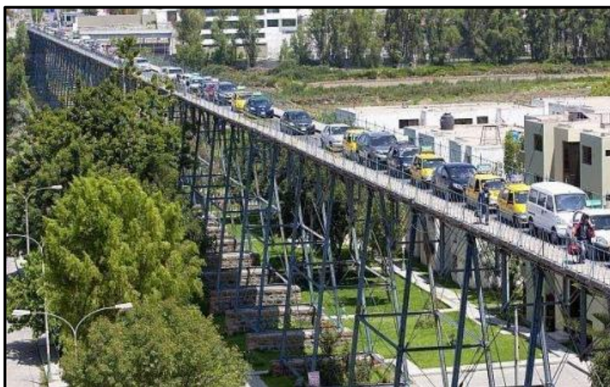
Figura 36: Puente de fierro, Arequipa
