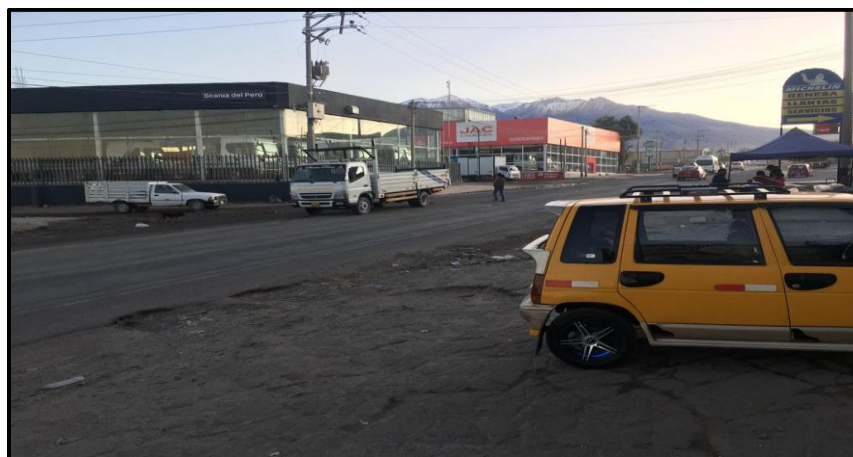
Figura 66: Estado actual del Km. 3.00 sin cruces peatonales.
