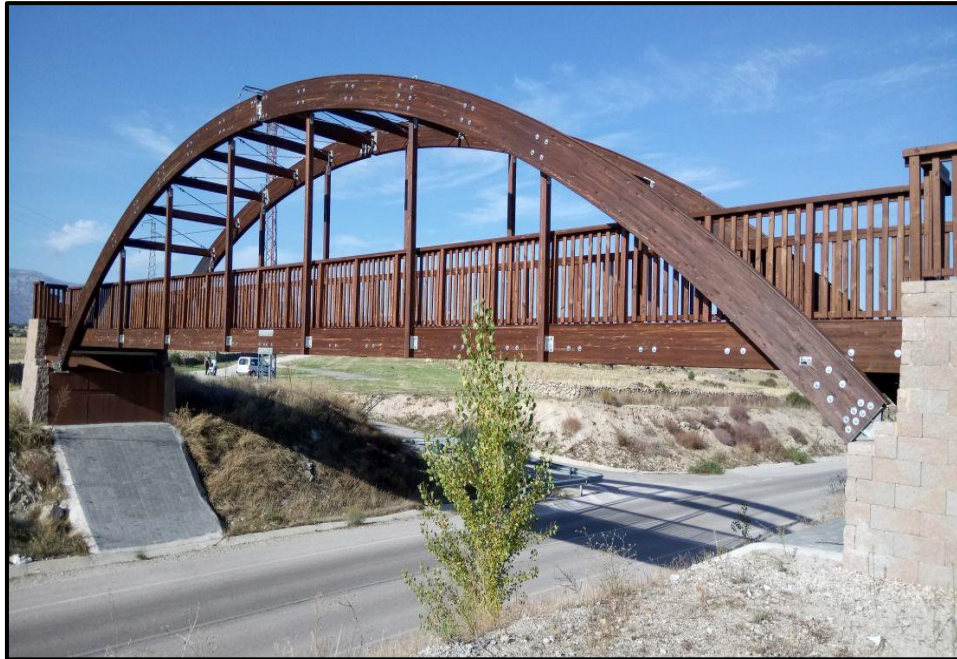
Figura 38: Puente peatonal, Madrid, 30 m.
