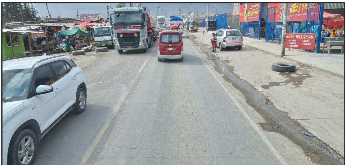
Figura 12: Inexistencia de señalización.
