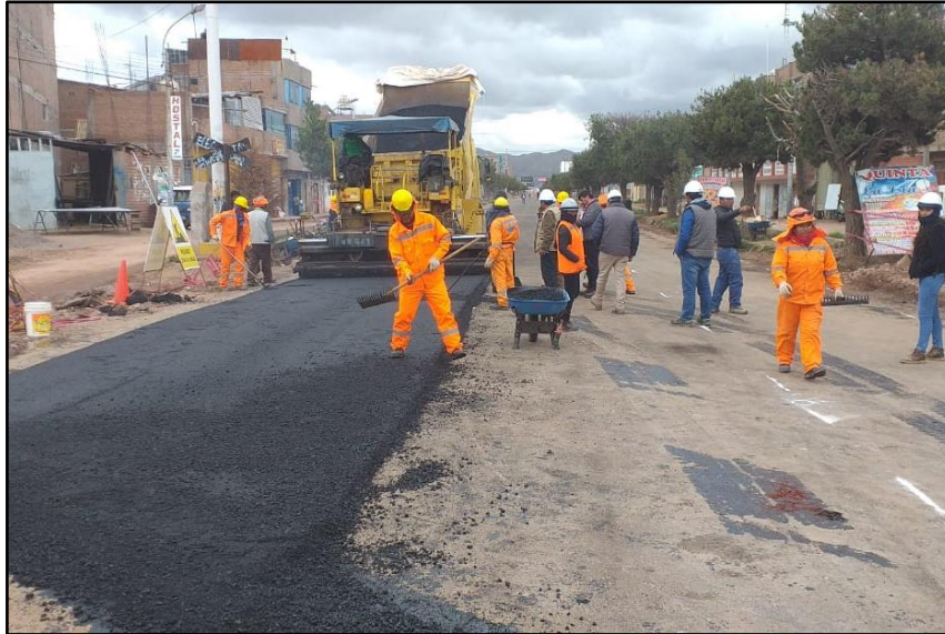
Figura 13: Colocación de mezcla asfáltica en caliente con pavimentadora.
