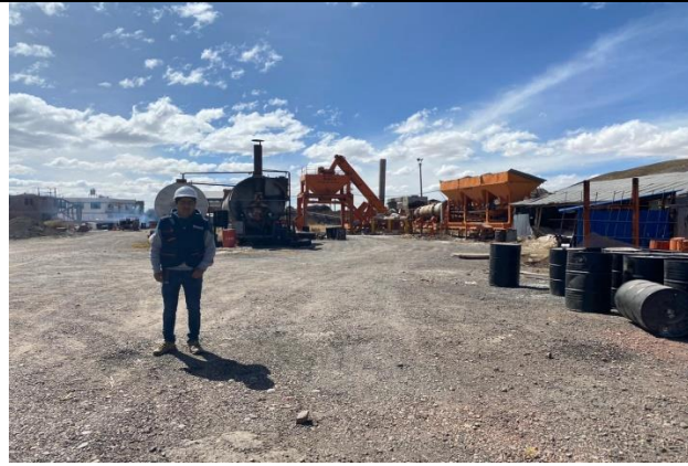
Figura 1: Visita a la planta de asfalto
