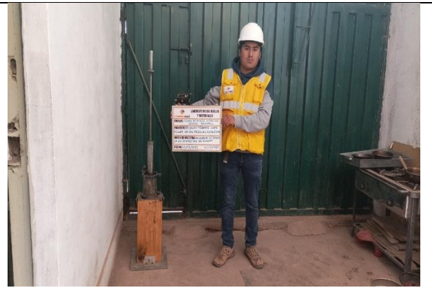
Figura 10: Compactación de la Mezcla Asfáltica.
