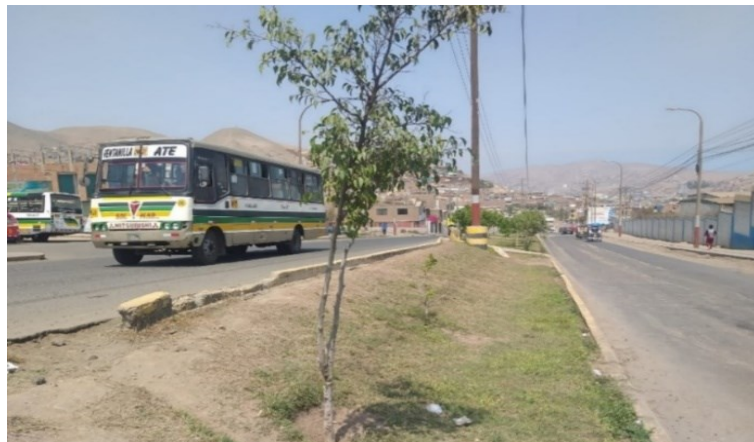
Figura 25: Delimitadores espaciales en mal estado y deficientes
