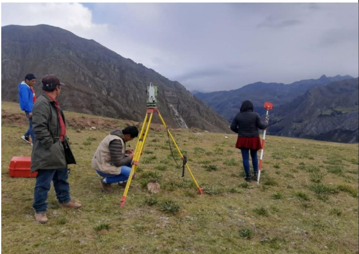
Realizando un levantamiento topográfico y verificando los puntos.
