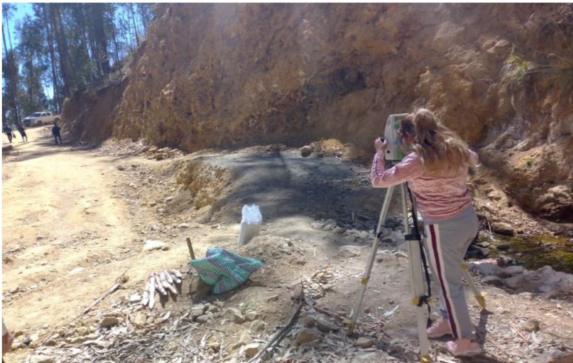
Realizando el levantamiento topográfico en el tercer tramo KM 0+000-3+000
