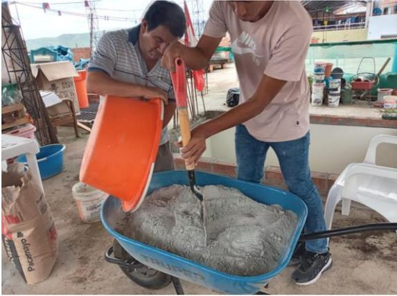
Foto 25: Mezcla de cemento, arena, microsíllica
