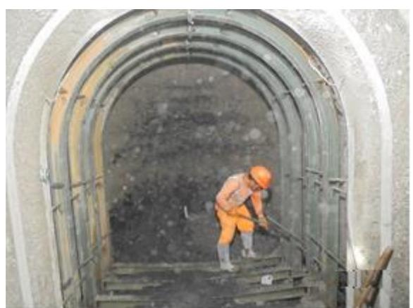
Foto 04: Sostenimiento de roca tipo Vs
