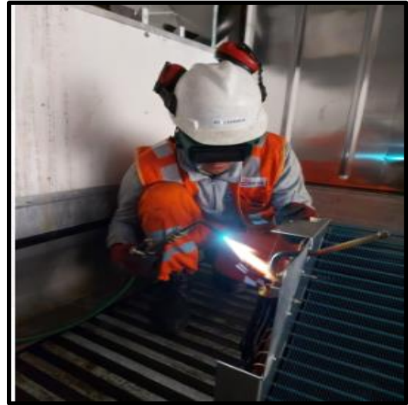
Figura 29: Instalación del Evaporador
