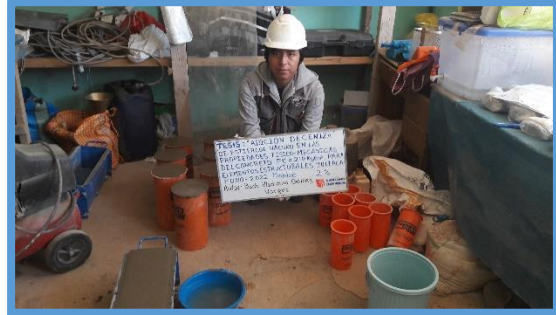
Figura 34. Moldeo de 2% concreto
