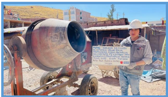
Figura 7. Fabricación del concreto.
