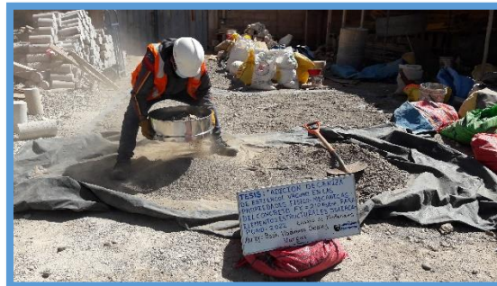
Figura 6. Tamizado de los agregados
