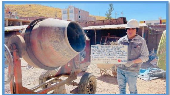
Figura 16. Elaboración del concreto patrón
