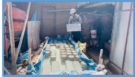
Figura 10. Curado del concreto
