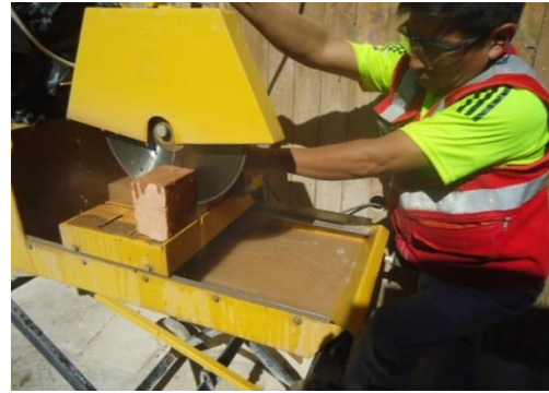
Foto N° 14: Corte de los ladrillos en mitades.
