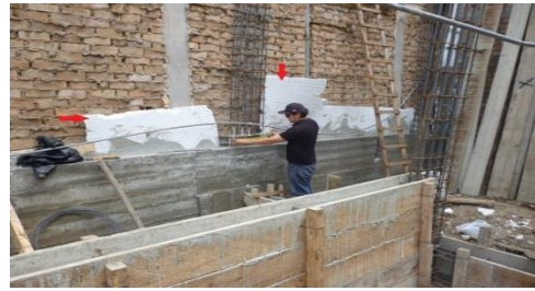
Figura N° 16: Instalación de tecnopor para junta sísmica
