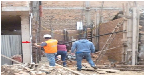
Figura N°15: colocado de tecnopor para junta sísmica
