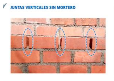
Figura N° 7: Juntas verticales libres sin mortero en una jornada de trabajo
