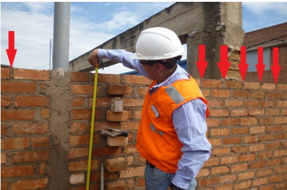
Fotografía N°2: Juntas verticales llenas con mortero en una jornada de trabajo, vivienda ubicada en Av. Héroes del Cenepa.
