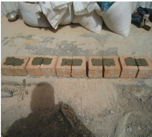
Fotografía N° 15: Ladrillos con capping
