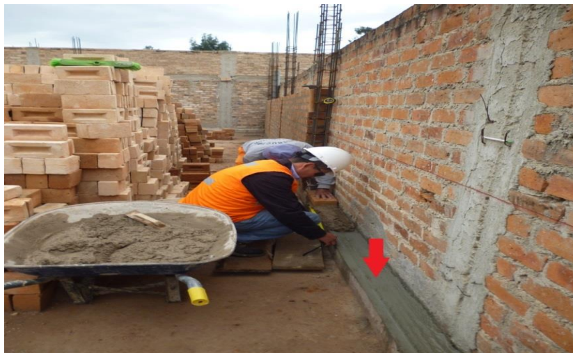
Fotografía N° 8: Superficie de concreto en el sobrecimiento no rayado; por consiguiente no rugoso, en la vivienda ubicada del Jr. San Luis.
