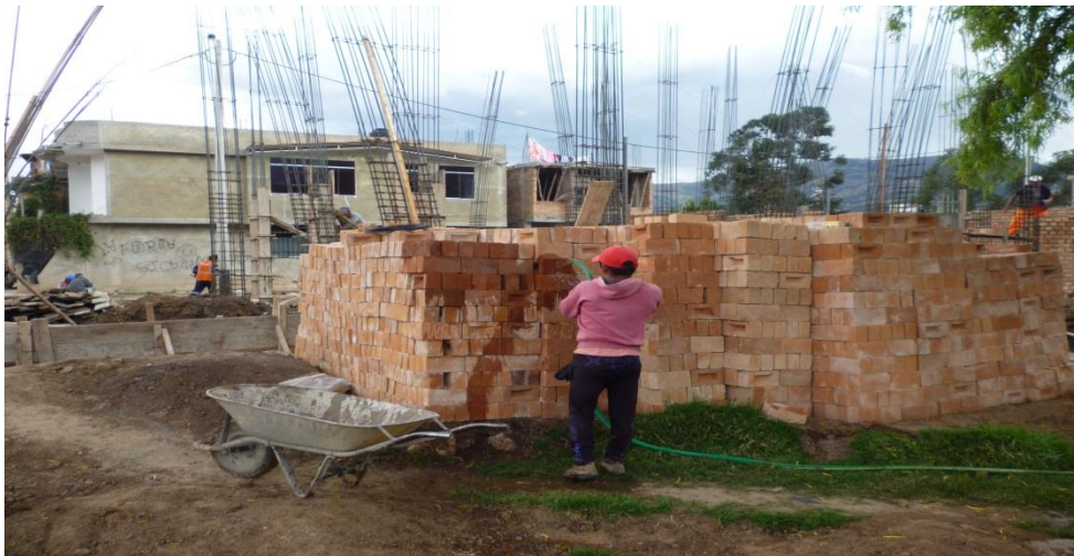
Fotografía N°10: Humedecido de los ladrillos artesanales el mismo día del asentado, en la vivienda ubicada en la Calle Virgen del Rosario
