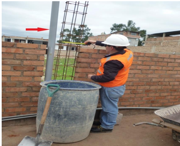
Fotografía N°6: Instalación de tubería entre columna y muro, en la vivienda ubicada en el Jr. San Luis y Jr. Fernando Belaunde Terry.
