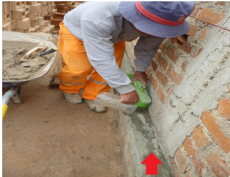
Fotografía N° 7: Humedecido del sobrecimiento con lechada de cemento, en la vivienda ubicada del Jr. San Luis.
