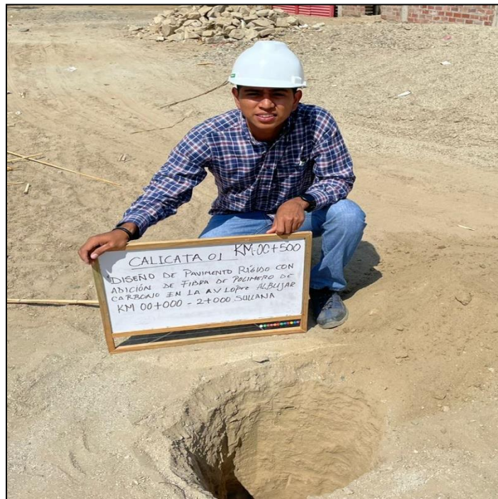
Calicata N° 1 - Km 00+500
