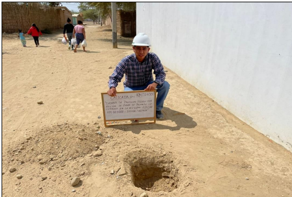
Calicata N° 4- Km 2+000
