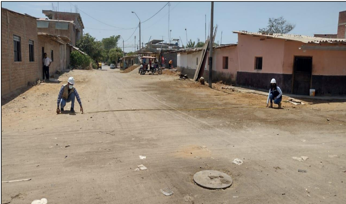
Toma de medidas de ancho de calzada la Avenida López Albújar (Km 00+500)
