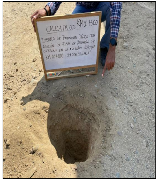
Calicata N° 3- Km 1+500
