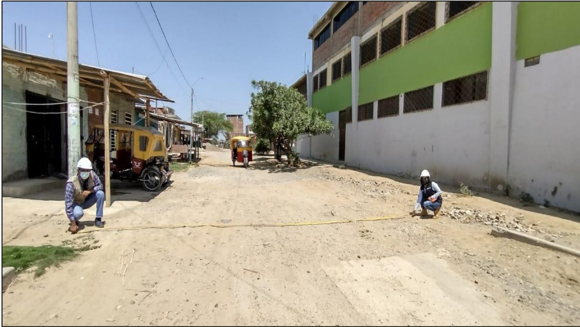
Toma de medidas de ancho de calzada la Avenida López Albújar (Km 1+1500)
