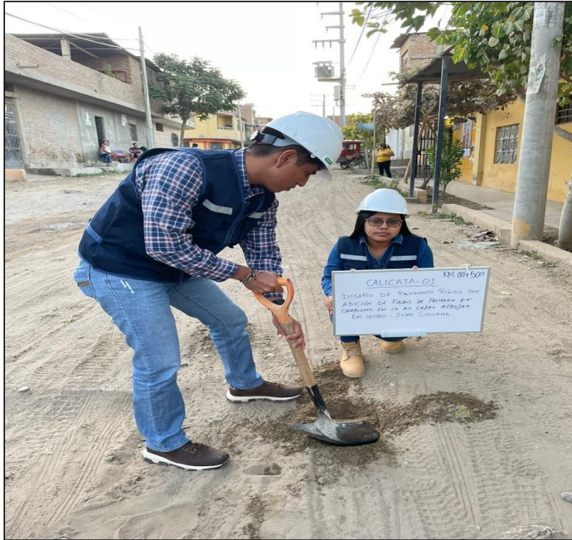
Calicata N° 1 en la Avenida López Albújar
