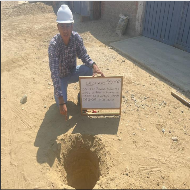
Calicata N° 2 - Km 1+000
