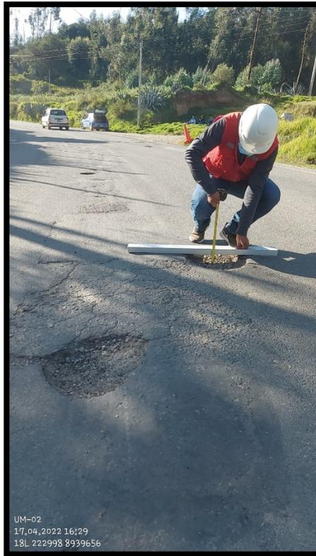
*Fotografía N° 03: Medición de la profundidad de los huecos en el pavimento flexible para determinar el impacto de los daños.*
