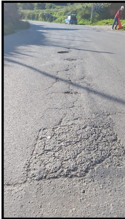
*Fotografía N° 07: Se observó la presencia de las siguientes fallas: piel de cocodrilo y parches.*
