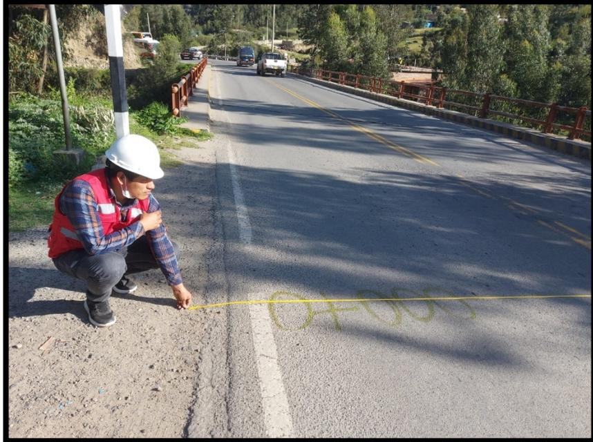
*Fotografía N° 01: Punto de partida – Puente Pariac, se realizó la medición del ancho de vía para sectorizar las unidades de muestra.*
