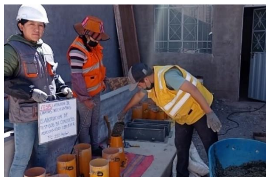
Figura 21. Revenimiento del concreto
