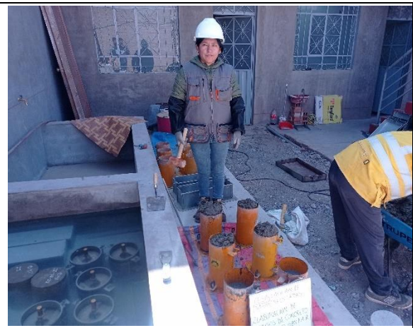
Fotografía N° 26: Elaboración de briquetas cilíndricas de concreto
