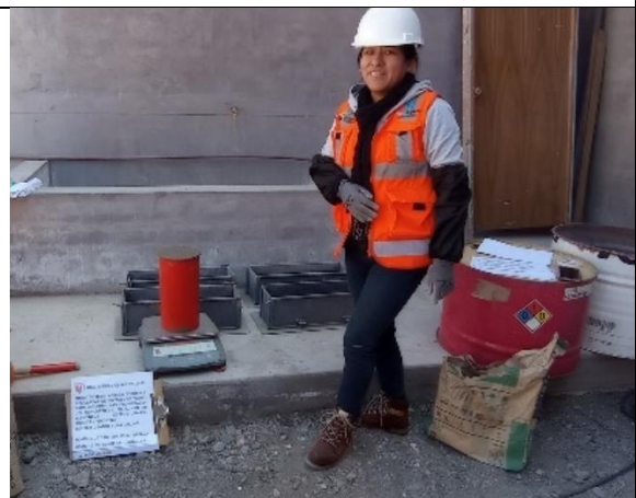
Fotografía N° 24: Control de calidad del concreto – peso unitario
