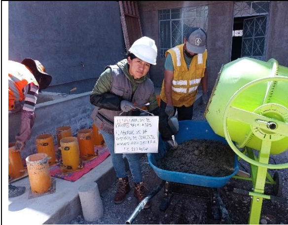
Fotografía N° 19: Control de calidad del concreto - temperatura
