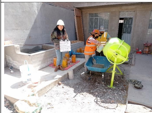
Fotografía N° 17: Mezclado de materiales para el concreto
