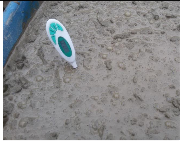
Fotografía N° 20: Control de calidad del concreto - temperatura
