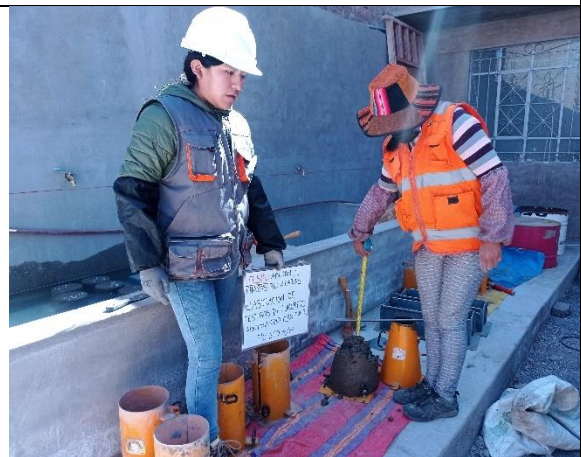
Fotografía N° 22: Control de calidad del concreto – revenimiento SLUMP
