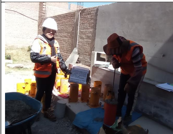
Fotografía N° 23: Control de calidad del concreto – peso unitario
