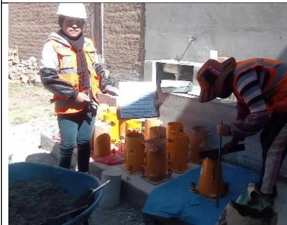
Fotografía N° 21: Control de calidad del concreto – revenimiento SLUMP
