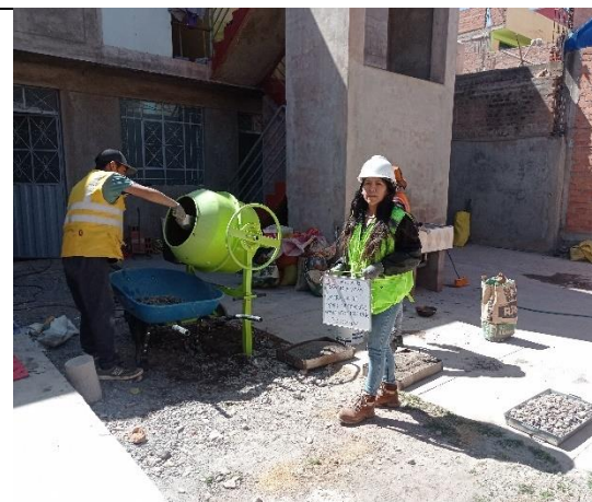
Fotografía N° 16: Inicio de mezclado de concreto
