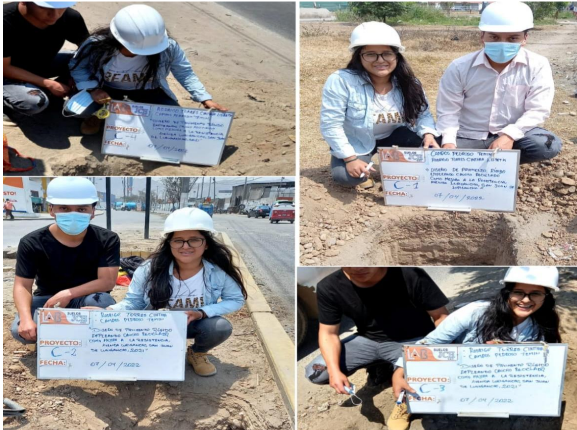
Figura 4. Excavación de calicatas
