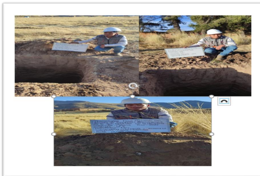
Figura 21 Calicatas C-1, C-2, C-3
