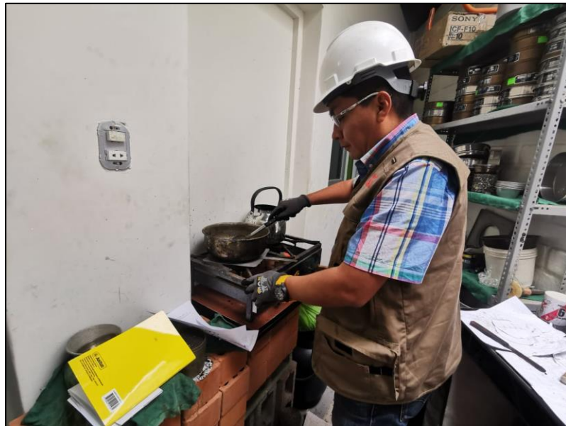
Toma 6. Mezcla de agregados.
