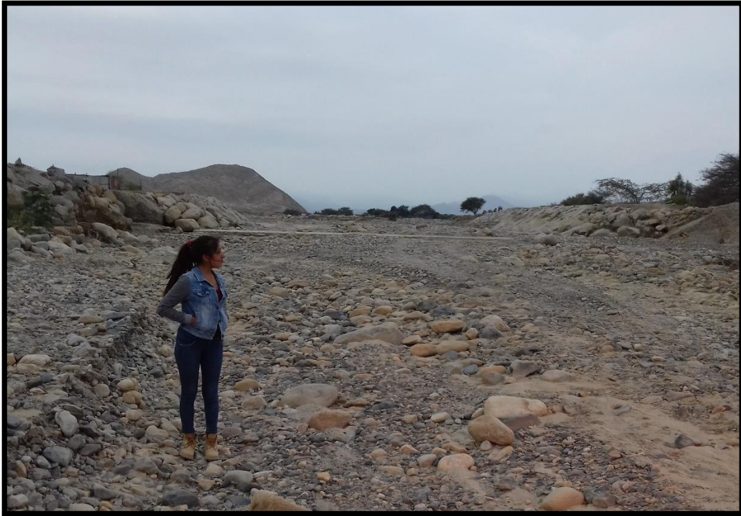
Imagen N°07: Acueducto Lacramarca, totalmente destruido.
