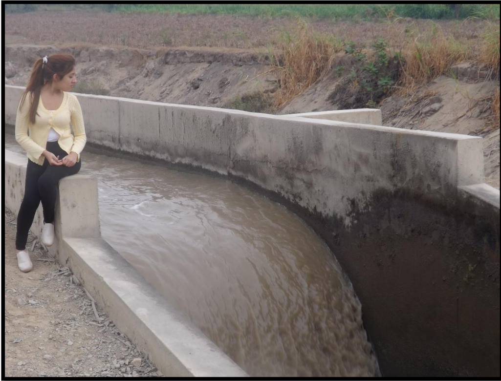
Imagen N°05: Visita Canal Carlos Leigh.
