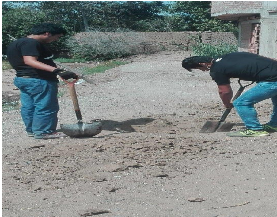
FOTO N°8 :EXCAVACIÓN PARA LA CALICATA.
