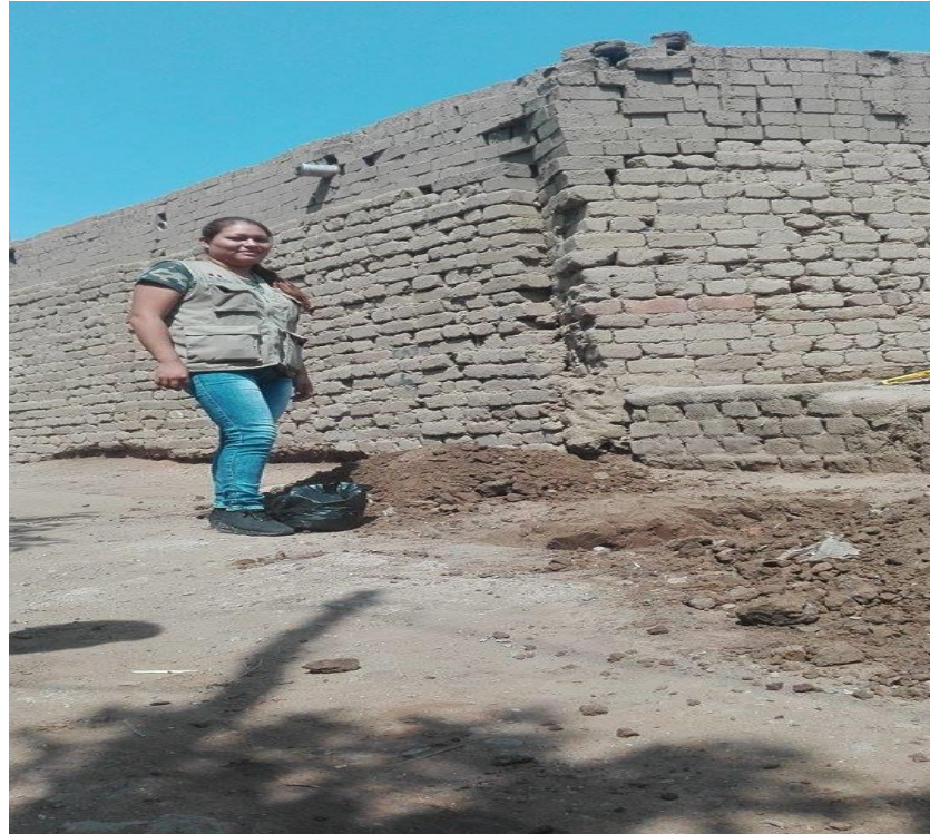
FOTO N°1: LOCALIZACIÓN DE LA ZONA DE ESTUDIO PARA REALIZAR LAS CALICATAS.
