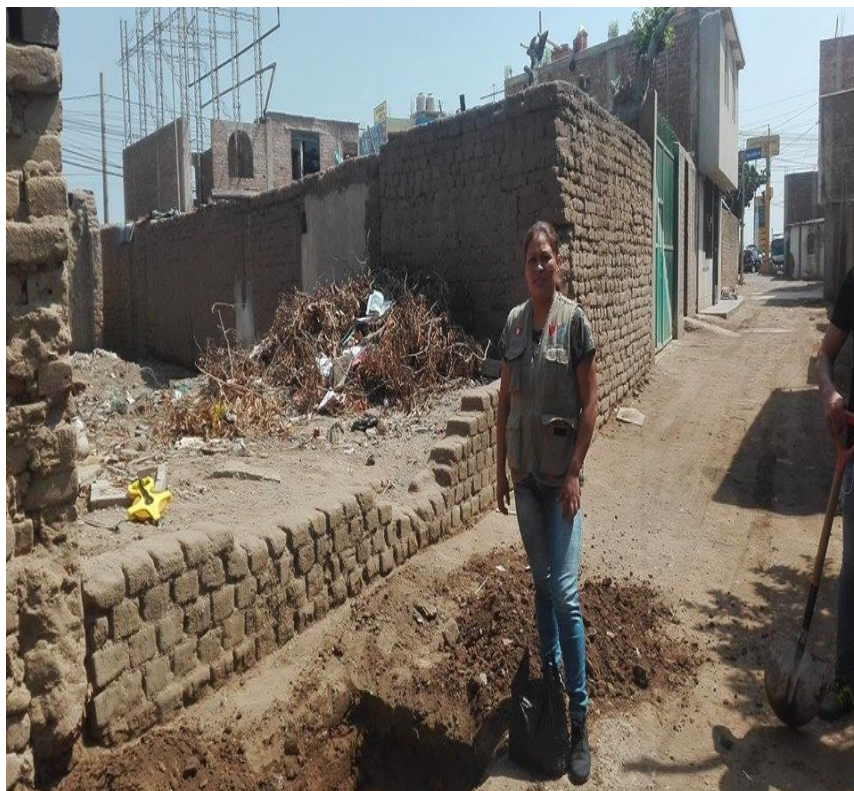
FOTO N°2: ENTRADA DE LA CAMPIÑA DE MOCHE –PRIMERA CALICATA (C-1).
