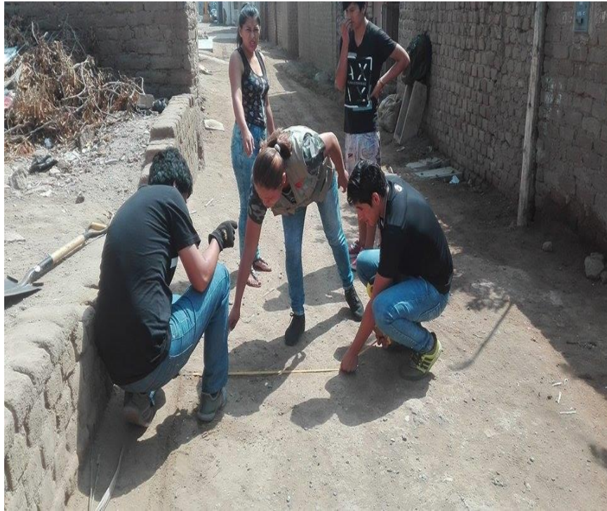
FOTO N°3:TRAZO Y MEDIDA PARA REALIZAR LA CALICATA.
