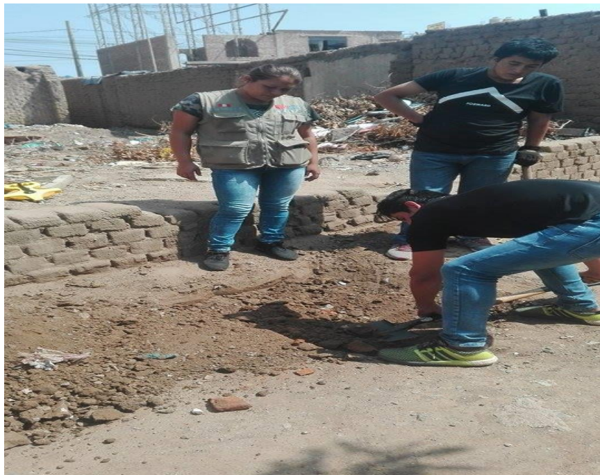
FOTO N°3:TRAZO Y MEDIDA PARA REALIZAR LA CALICATA.
