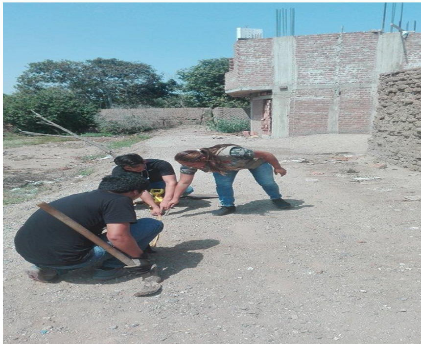
FOTO N°7 :TRAZO Y MEDIDA PARA REALIZARE LA CALICATA KM 2.
