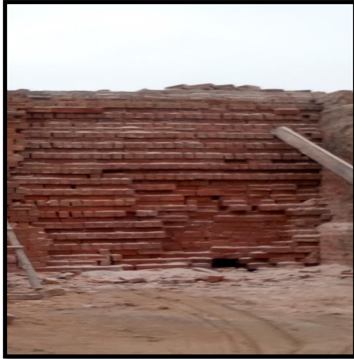
FOTO N° 37: SE ABRIÓ EL HORNO ARTESANAL PARA DEJAR QUE LOS LADRILLOS ENFRÍEN.
