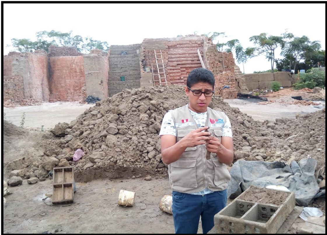
FOTO N° 04: ENSAYO DE PLASTICIDAD EN CAMPO (PRUEBA DEL ROLLO).
