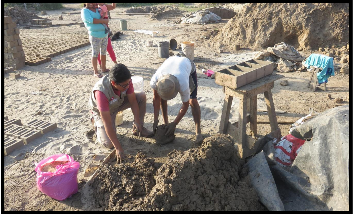
FOTO N° 17: VERIFICANDO QUE LA CONSISTENCIA DE LA MEZCLA SI CUMPLE CON LAS PROPORCIONES ADECUADAS, ELABORANDO UNA PEQUEÑA BOLA DE LA MEZCLA.
