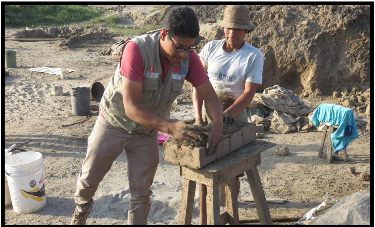
FOTO N° 20: EJERCIENDO PRESION SOBRE EL MOLDE, PARA COMPACTAR EL MOLDE DE LADRILLO.
