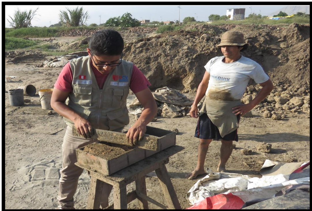
FOTO N° 21: CON UNA REGLA DE MADERA SE PRODECE A RETIRAR LOS EXCEDENTES DEL MOLDE, DESPUES DE SU PREVIO COMPACTADO.
