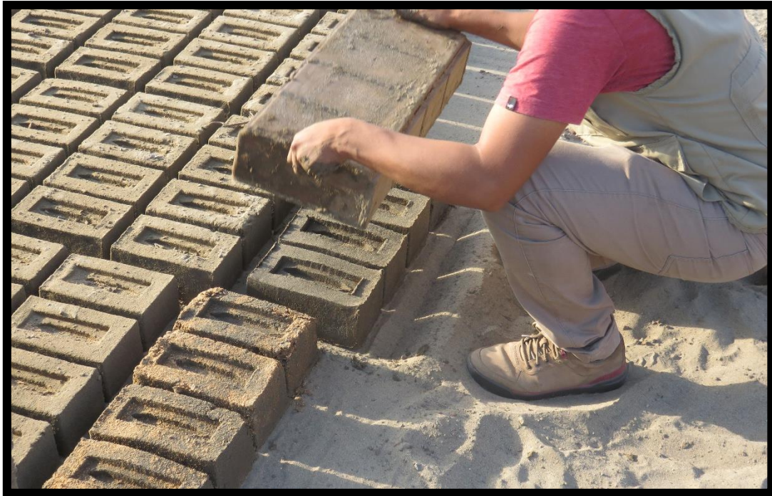
FOTO N° 25: SE RETIRA POR COMPLETO EL MOLDE DEL LADRILLO ARTESANAL.
