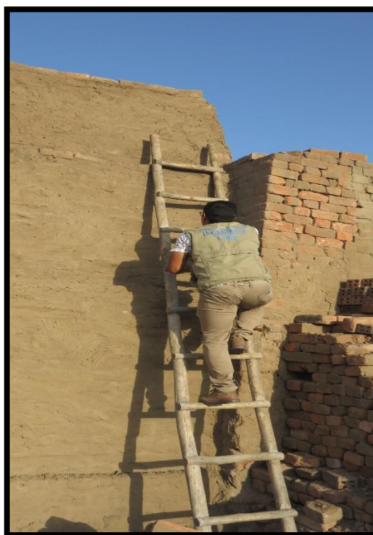
FOTO N° 34: VERIFICACIÓN DE LOS LADRILLOS COCIDOS.
