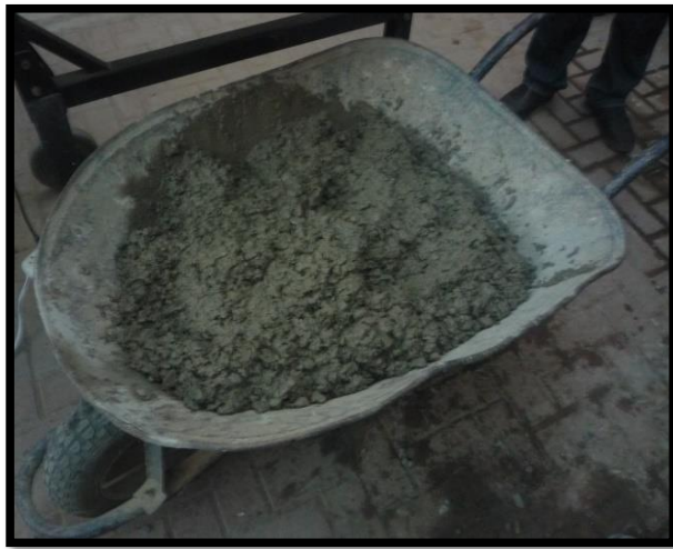
Fig. N° 14 y 15: echamos la mezcla en un bugí, y realizamos el slump para ver el asentamiento de la mezcla.
