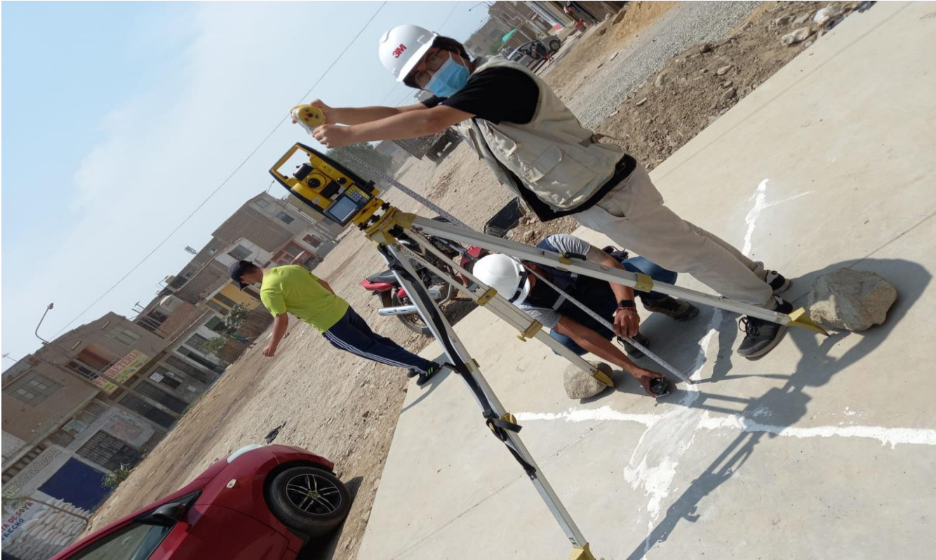
Foto 02: Estacionamiento de la estación total
