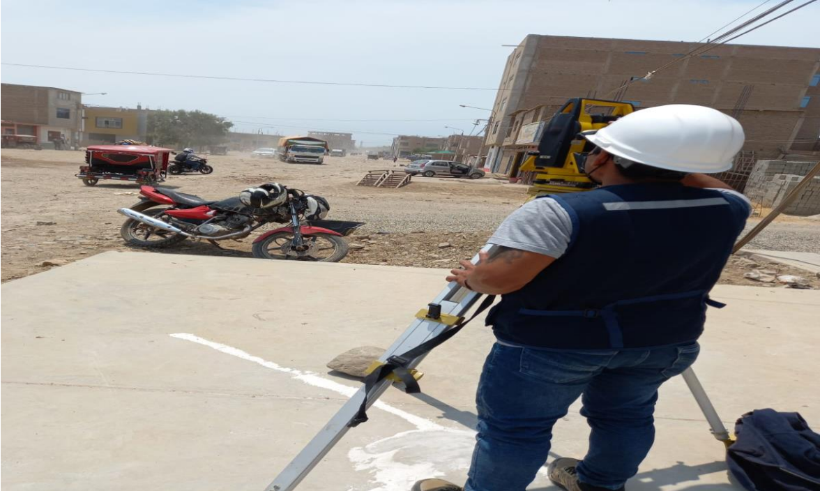
Foto 04: inicio del levantamiento topográfico
