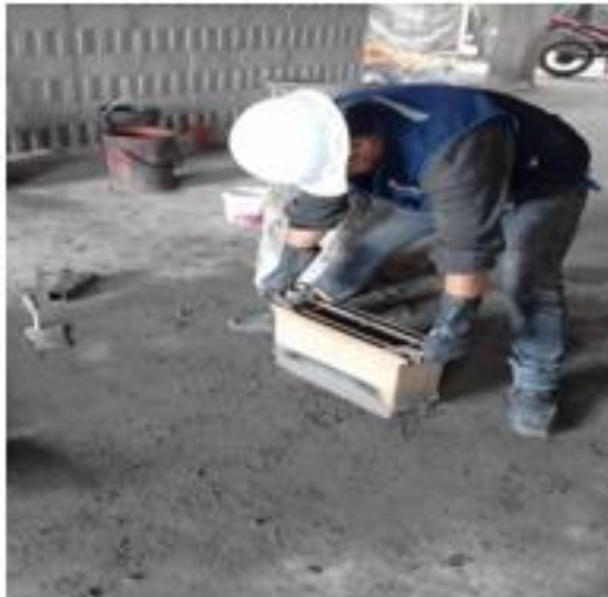
Fotografía 1: Fabricación de bloquetas.
