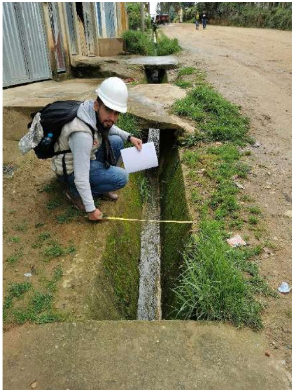
Figura 6: Presencia de Cunetas en el primer tramo (0+050.00KM).
