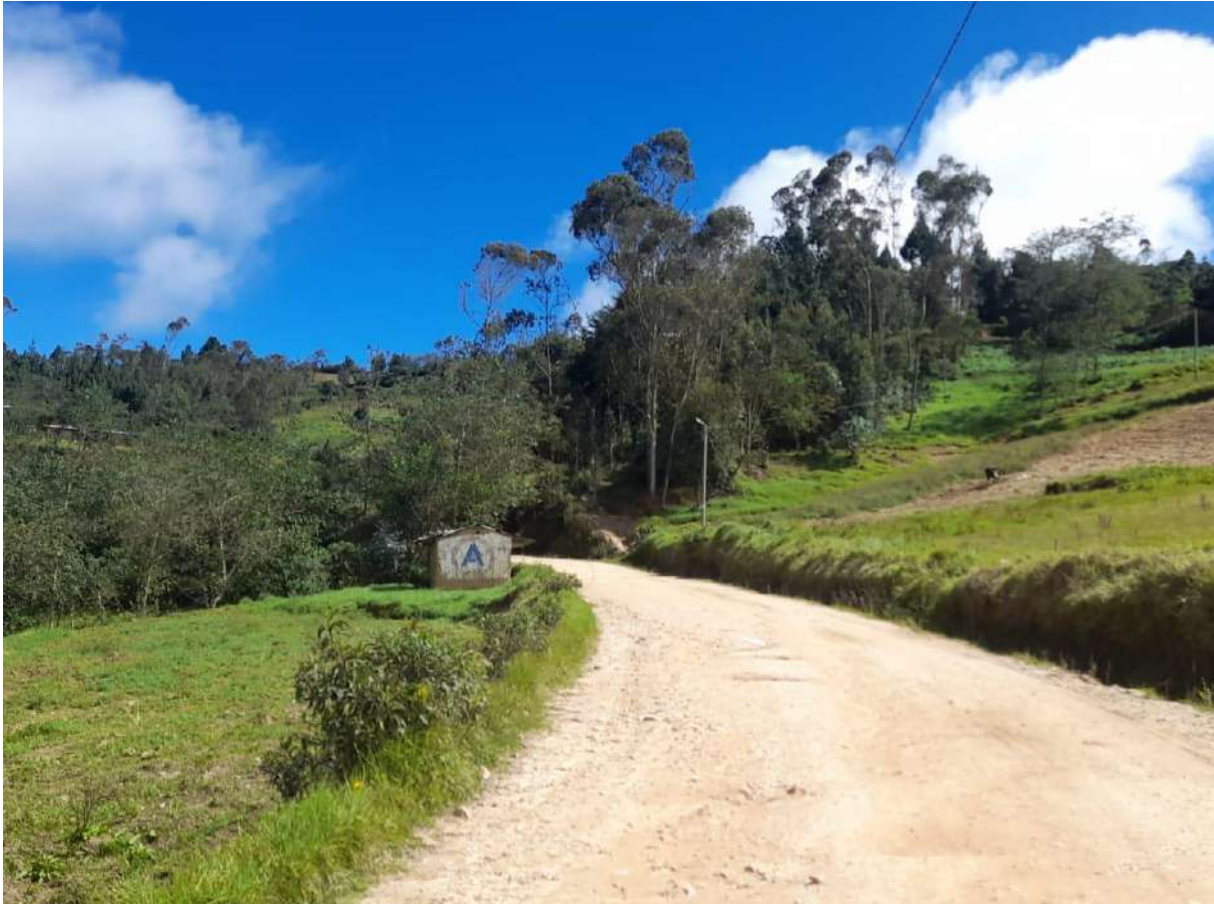
Figura 1: Tramo antes de Ejecución, se evidencia regular vegetación.
