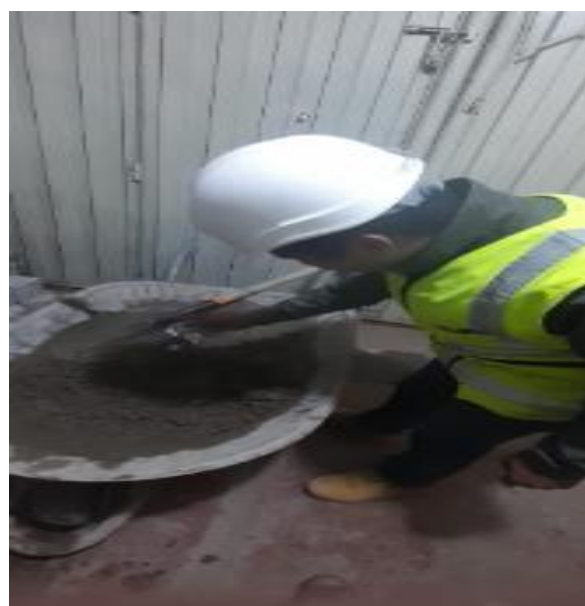
Fotografía 06: adicionando el aditivo natural
