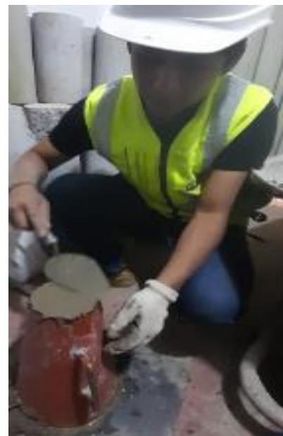
Fotografía 08: ensayo de trabajabilidad
