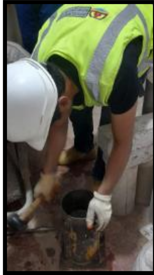
Prueba de masa unitaria del concreto
